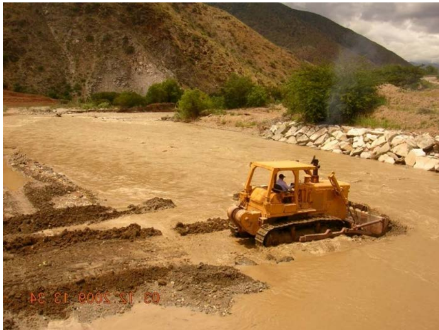
Imagen N° 4: limpieza de cauce con el apoyo del tractor.
