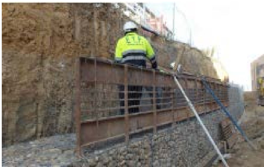
Imagen N° 13 – Esquema del Encofrado Exterior del Gavión.
