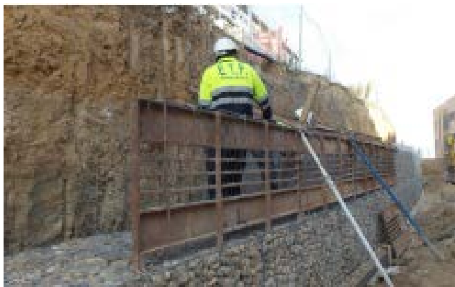
Imagen N° 17 – Esquema del Encofrado Exterior del Gavión.
