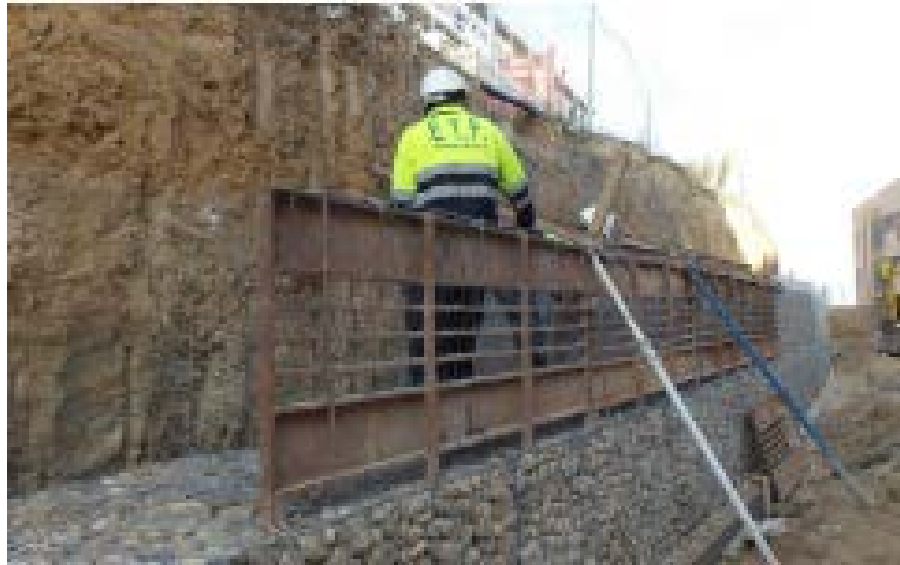
Imagen N° 9 – Esquema del Encofrado Exterior del Gavión.
