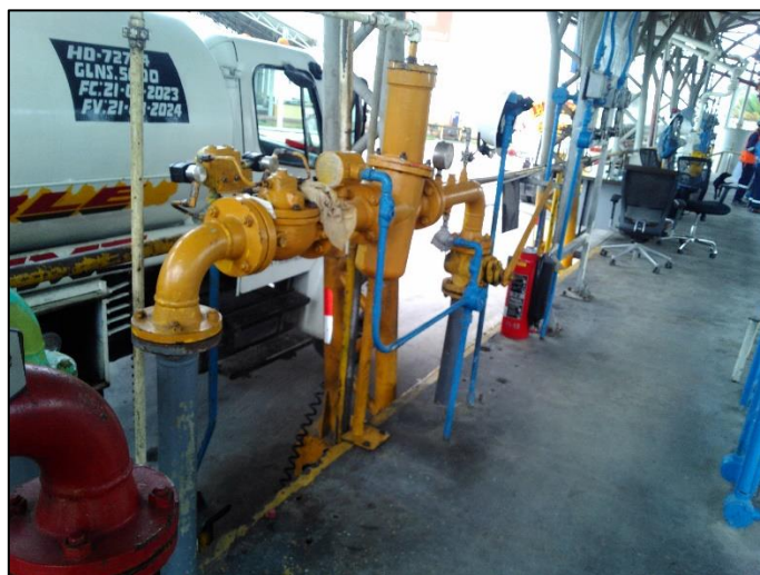
Figura 33. Contómetros tipo turbina
