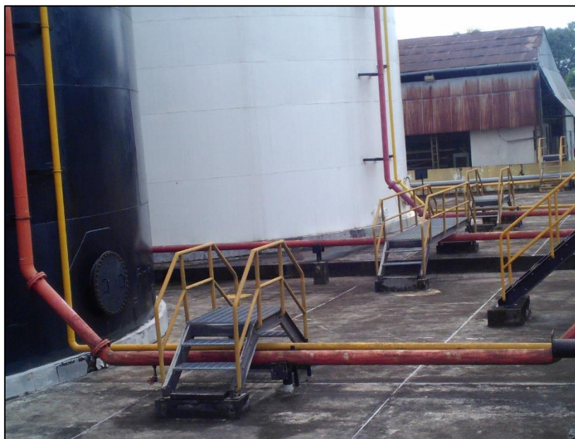
Figura 27. Área Estanca Impermeabilizada – Con Drenajes
