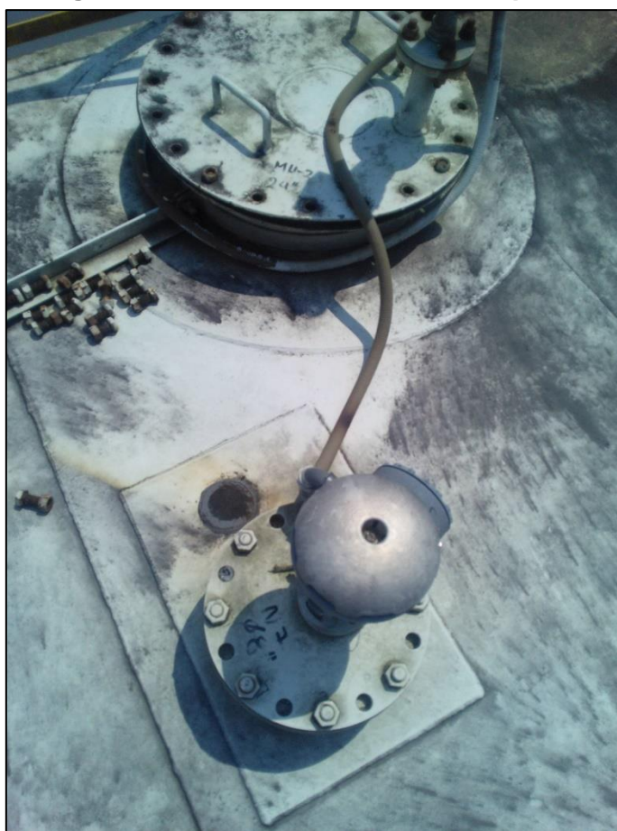
Figura 30. Válvulas de venteo en tanques
