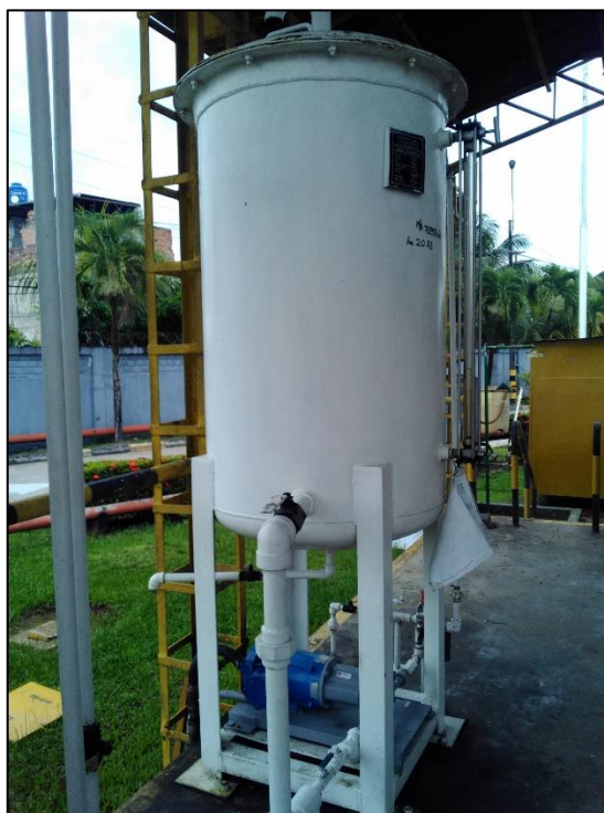
Figura 38. Sistema de inyección de aditivos químicos
