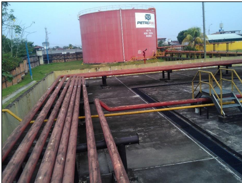
Figura 28. Área Estanca Impermeabilizada – Rack de Tuberías
