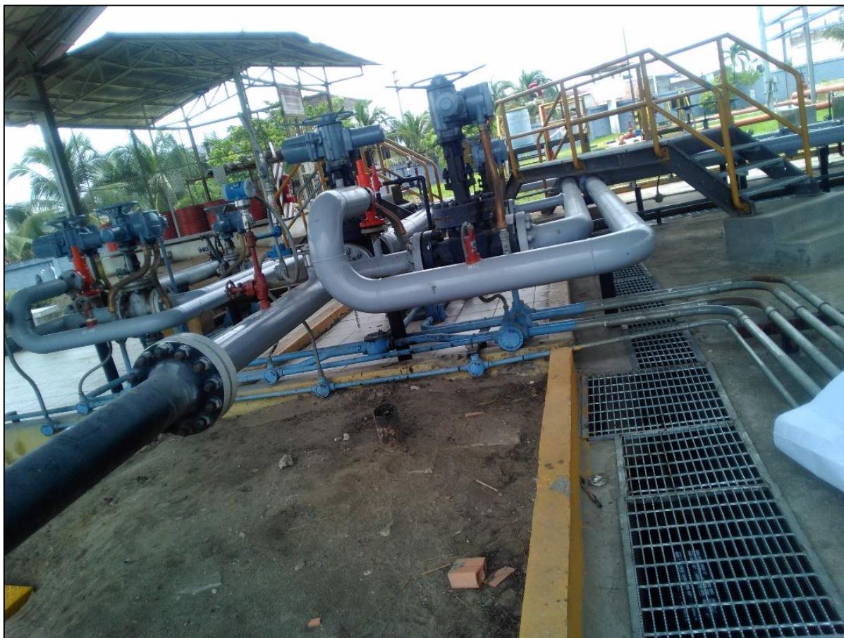
Figura 25. Sistema de Recepción del Poliducto
