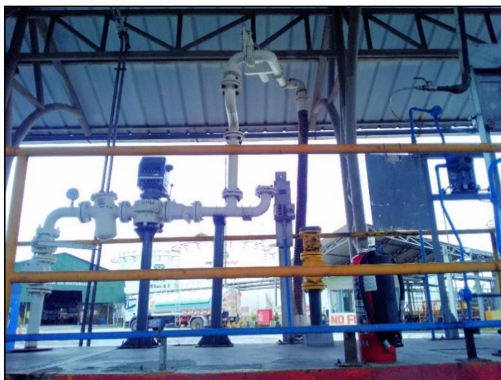
Figura 36. “Recuperación de vapores”
