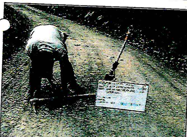
Foto 11: Verificación del espesor existente de afirmado E= 0.02 mts
