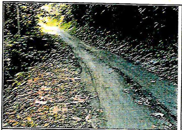
Foto 12: Baches y ahuellamientos
