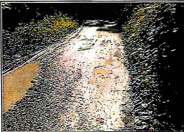
Foto 03: Baches y ahuellamientos
