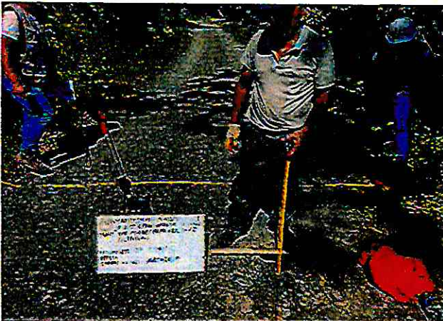
Foto 03: Verificación del espesor existente de afirmado E=0.02 mts
