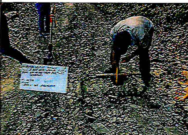
Foto 05: Verificación del espesor existente de afirmado E=0.03 mts
