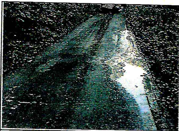
Foto 09: Baches y ahuellamientos
