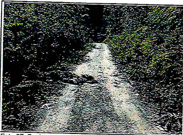
Foto 07: Baches y ahuellamientos
