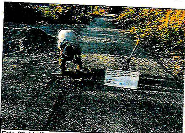
Foto 09: Verificación del espesor existente de afirmado E= 0.025 mts
