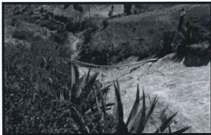
Toma Lc_01: Se muestra la línea de conducción PVC y F°G° Ø2" que abastece a los sectores; la misma que se muestra expuesta y vulnerable.
