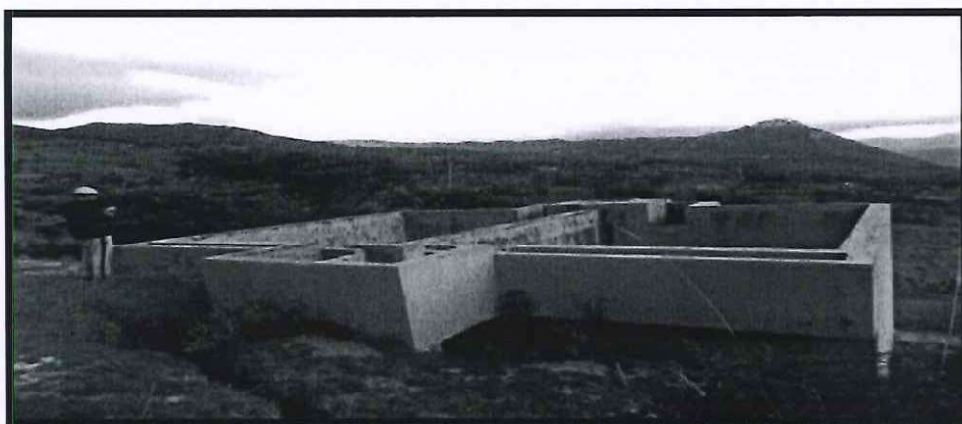
Toma FI_02.- Nótese otra toma del Filtro lento, que será demolido por no cumplir con el caudal requerido, para cubrir la demanda.
