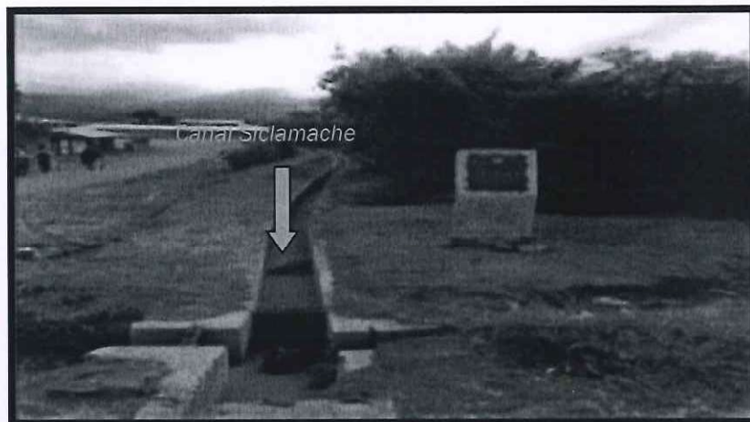
Toma _01: Vista panorámica Canal Limón – Siclamache, donde se puede apreciar que se encuentra revestido de concreto, el mismo que cruza por el Centro Poblado Siclamache.
