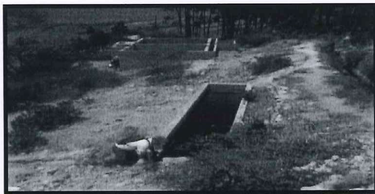
Toma Sed_01: Vista panorámica del Sedimentador Nótese que no cuenta con cerco y estado deteriorado de la estructura.
