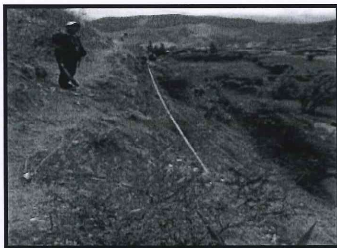
Toma Lc_02: Se muestra la línea de conducción PVC y F°G° Ø2" que abastece a los sectores; la misma que se muestra expuesta y vulnerable.
