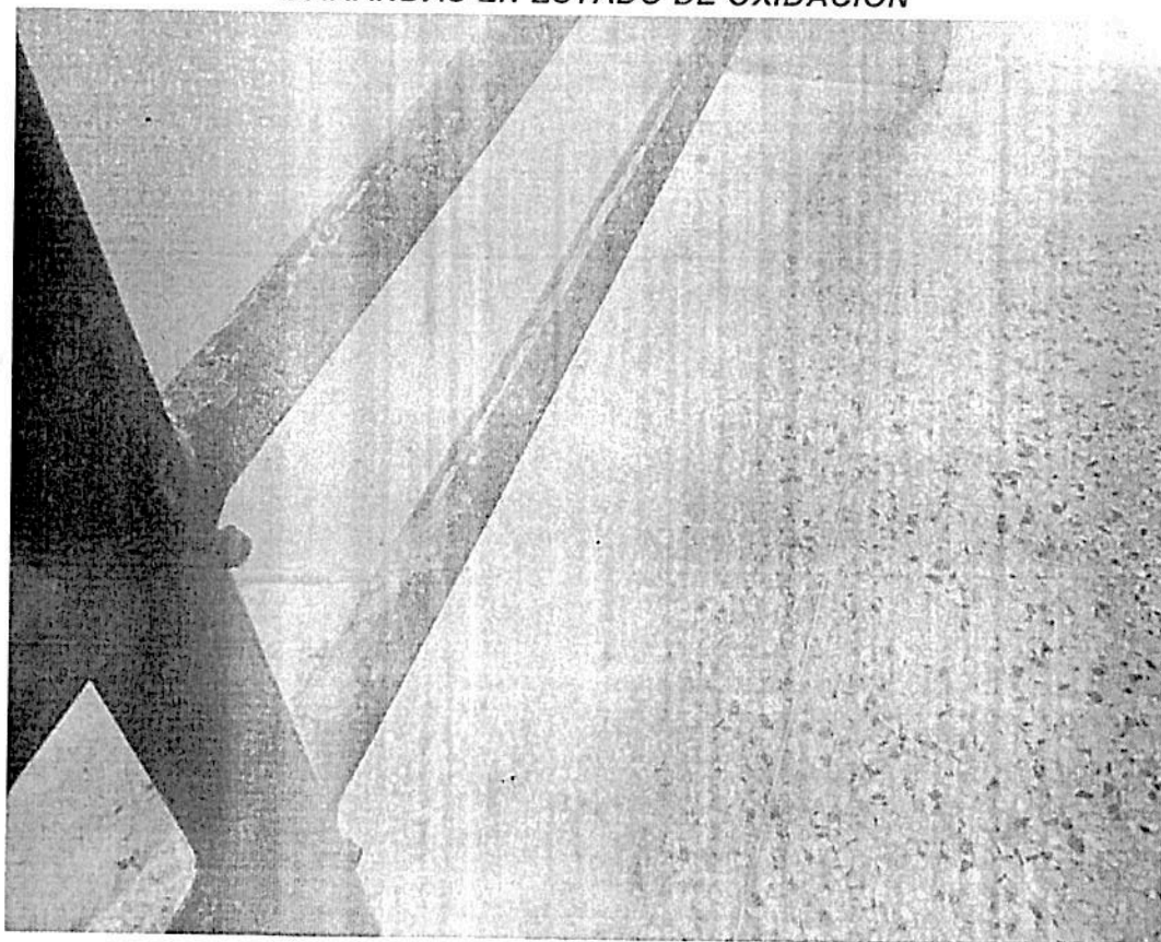
BARANDAS EN ESTADO DE OXIDACIÓN
