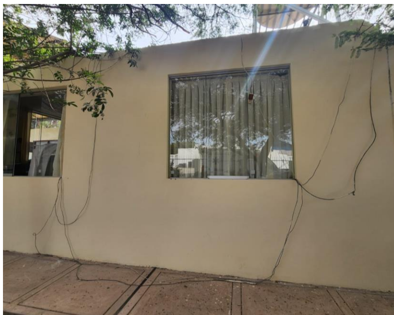
F1: Canalizado de cables expuestos
