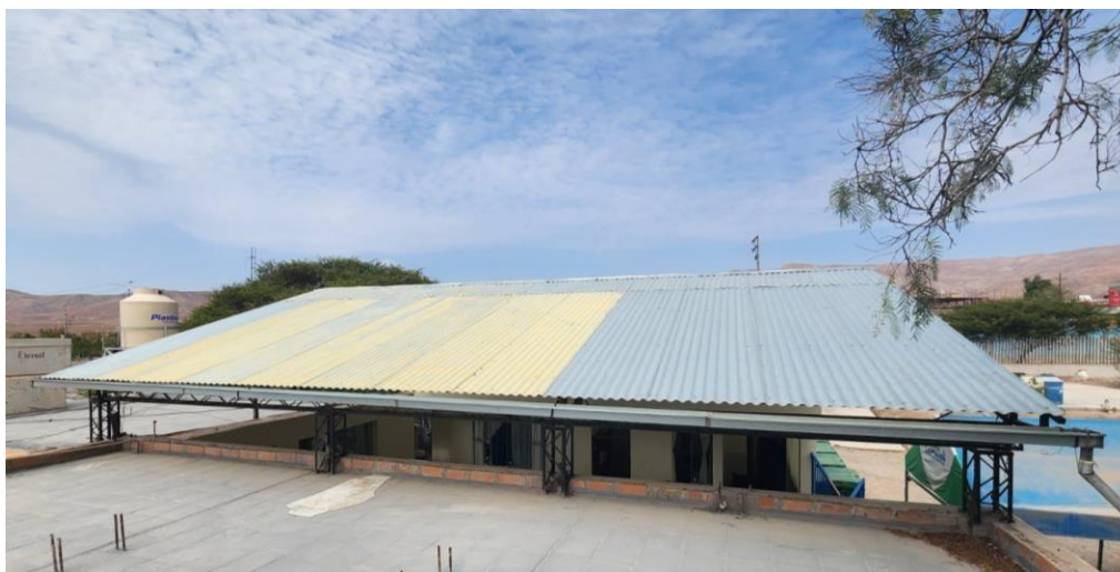
F3: Retiro y reposición de cobertura Aluzinc - TR4
