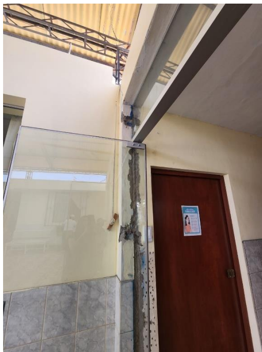
F7: Resane de columnas dañadas por desmontaje anterior
