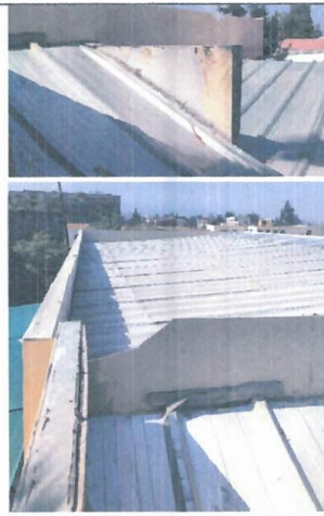
Figura 04: Segundo Nivel, Módulo 3: Presencia de 3 pendientes diferentes en el techo complicando la evacuación de aguas pluviales.
