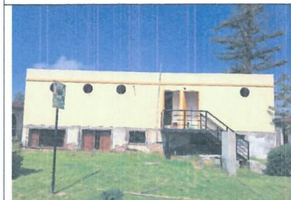
Figura 19: Exterior Segundo Nivel, Modulo 1: Psiquiatría: Bajada de lluvias sin adosamiento y colocado de manera arbitraria, Puerta con desprendimiento de pintura y acabados. Placas drywall de muro exterior y derrames con lesiones. Físicas: humedad de filtración. Mecánicas: desprendimiento de acabados, descascaramiento de pintura base y desprendimiento de cinta de unión
