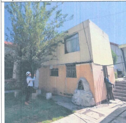
Figura 11: Exterior Segundo Nivel, Modulo 2: Planchas de drywall de muros con presencia de lesiones físicas de tipo mancha por moho, Muros expuestos a degradarse por efecto de lluvias, cableado expuesto con ausencia de canalizaciones o entubados.
