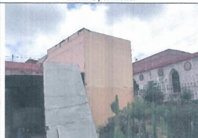
Figura 20: Exterior Segundo Nivel, Modulo 1: Psiquiatría: Placas drywall de muro exterior y derrames con lesiones. Físicas: humedad de filtración. Mecánicas: desprendimiento de acabados, descascaramiento de pintura base y desprendimiento de cinta de unión
