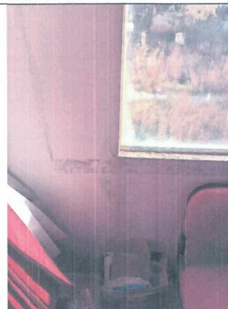
Figura 06: Segundo Nivel, Modulo 3: Consultorios de Psiquiatría: Planchas de drywall de muro interior con presencia de lesiones físicas de tipo mancha por moho, lesiones mecánicas en derrames de vanos desprendimiento de acabados, descascaramiento de base y pintura
