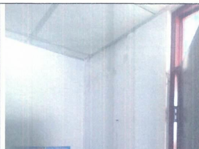
Figura 18: Segundo Nivel, Modulo 2: Consultorios Psicología: Planchas de drywall de muros interiores y exteriores con presencia de lesiones físicas de tipo mancha por moho.
