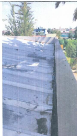
Figura 03: Segundo Nivel, Módulo 3: Techos con falta de mantenimiento y limpieza.
