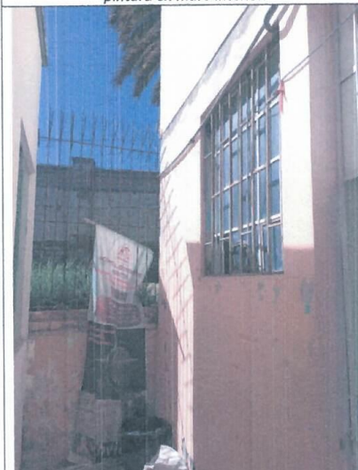
Figura 33: Primer Nivel, Modulo 3: Psicología: Desprendimiento de acabados, base y pintura en muro. Ventanas con desgaste de acabados, pintura, marco y accesorios.
