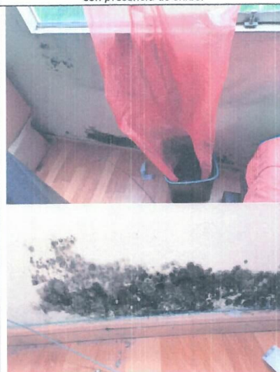
Figura 25: Segundo Nivel, Modulo 1: Psiquiatría: Planchas de drywall de muros interiores y exteriores con presencia de lesiones físicas de tipo mancha por moho.
