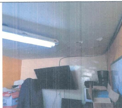
Figura 32: Primer Nivel, Modulo 2: Psiquiatría: Descascaramiento de acabados, pintura y base en cielo raso y muros interiores. Presencia de humedad en pared, salitre y desprendimiento de acabados, base y pintura en muro interior.
