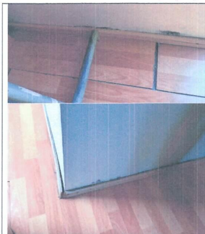
Figura 27: Segundo Nivel, Modulo 1: Psiquiatría: Deformación y rotura de las piezas de piso Laminado, zócalo y perfil de transición por humedad.
