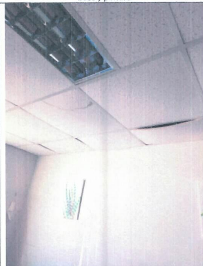
Figura 08: Segundo Nivel, Modulo 3: Baldosas de cielo raso con presencia de manchas por humedad, deformación y rotura.
