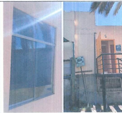
Figura 02: Segundo Nivel, Módulo 3: Ausencia de anclaje de tuberías de drenaje pluvial, Puerta con desprendimiento de pintura y acabados, Vidrios con presencia de fisuras.
