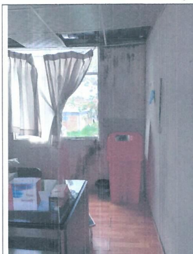
Figura 13: Segundo Nivel, Modulo 2: Canaletas de drenaje pluvial ubicadas al interior, con falta de mantenimiento, genera que resuma el agua pluvial por las paredes. Lesiones Físicas en muros drywall: humedad de filtración, tipo mancha por moho. Mecánicas: desprendimiento de acabados, descascaramiento de pintura base y desprendimiento de cinta de unión.
