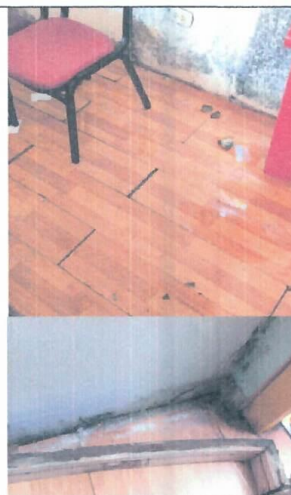
Figura 14: Segundo Nivel, Modulo 2: Deformación y rotura de las piezas de piso Laminado, zócalo y perfil de transición por humedad.
