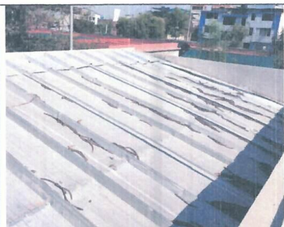
Figura 24: Segundo Nivel, Modulo 1: Psiquiatría: Techos con falta de mantenimiento y limpieza. Presencia de deformaciones en cobertura.
