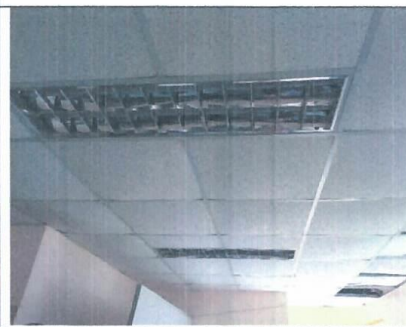
Figura 22: Segundo Nivel, Modulo 1: Psiquiatría: Baldosas de cielo raso con presencia de manchas por humedad, deformación y rotura.
