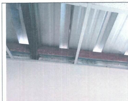
Figura 23: Segundo Nivel, Modulo 1: Psiquiatría: Canaletas de drenaje pluvial ubicadas al interior, con falta de mantenimiento, genera que resuma el agua pluvial por las paredes. Estructura metálica del techo con presencia de oxido.
