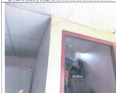
Figura 21: Segundo Nivel, Modulo 1: Psiquiatría: Instalaciones de Data colocadas arbitrariamente rompiendo baldosas, sin canalización ni entubadas.
