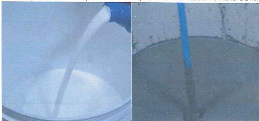
FIGURA 2: COLOCACION Y MEZCLA DE LOS DOS COMPONENTES (A+B)
