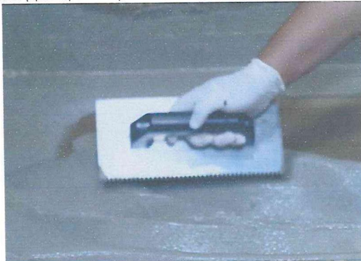
FIGURA 3: COLOCACION DE 1RA CAPA
