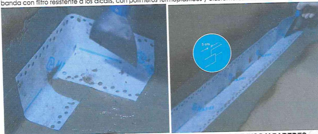
FIGURA 6: COLOCACION DE MAPEBAND EN EL ENCUENTRO DE PISO Y PAREDES
