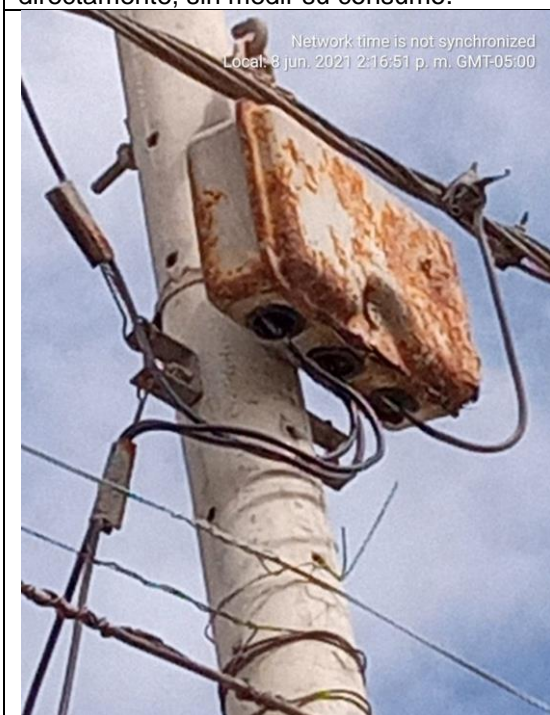
Caja de derivacion en estado de oxidacion
