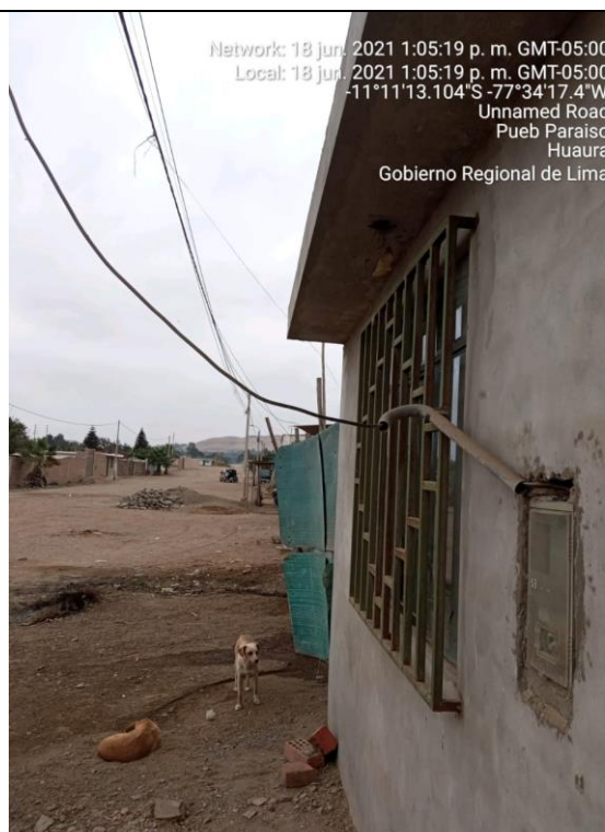
Acometidas en mal estado.
