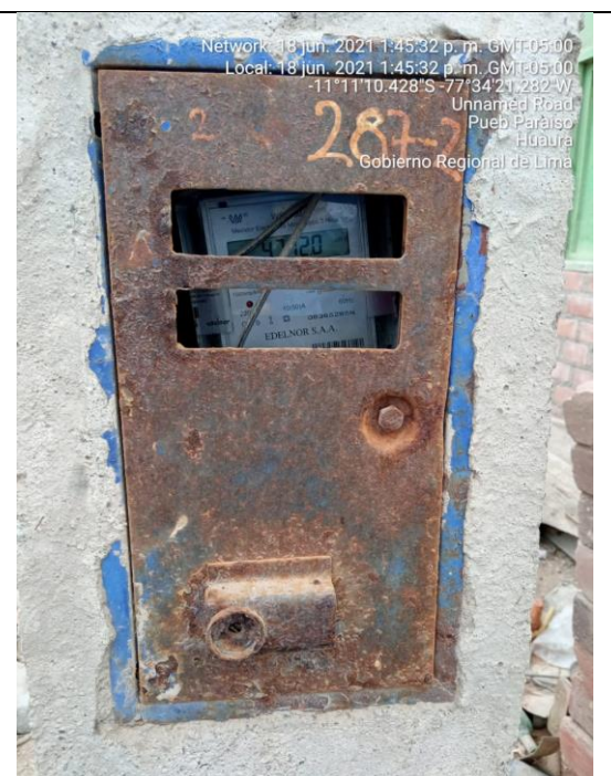
Acometidas en mal estado.
