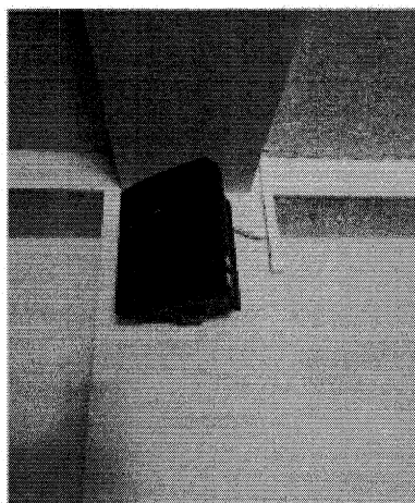
Parlantes empotrados a la pared girables y con el canaletado estético
