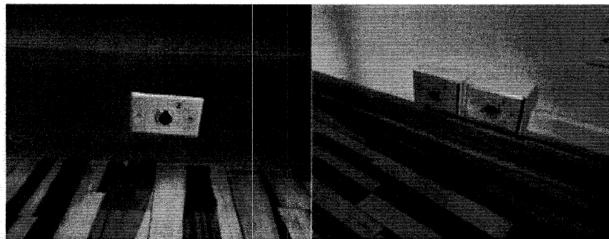
Conectores para micrófonos de pared, también adaptables en el piso
