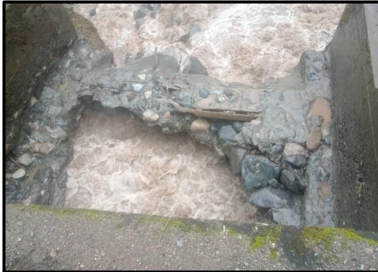
IMAGEN N° 012. FOTOGRAFIA DEL PUENTE MELLIZOS CON DAÑOS - ZOCABAMIENTO
