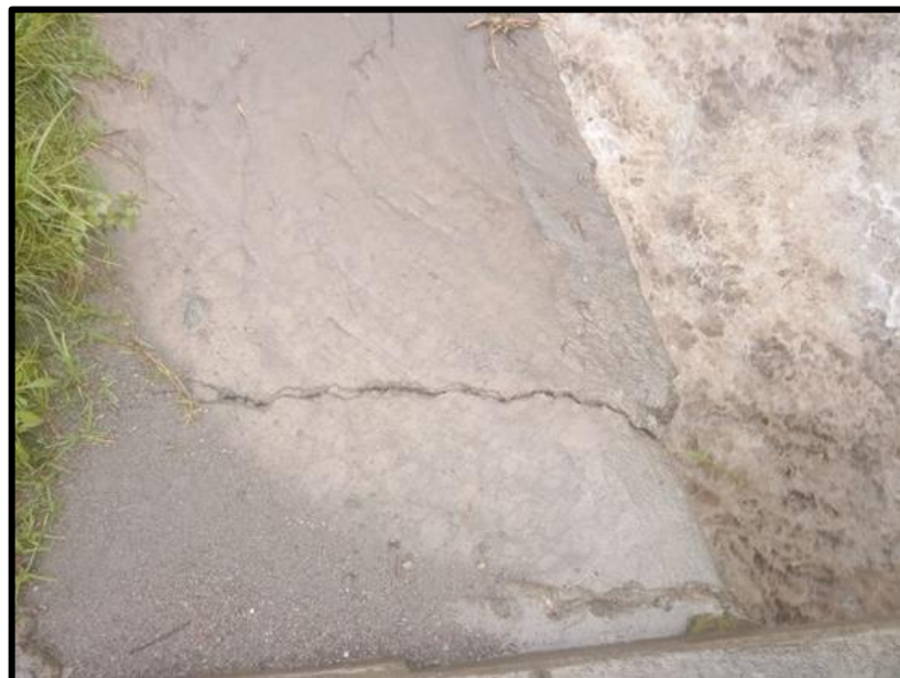
IMAGEN N° 010. RAJADURAS DE MUROS DE PUENTE
