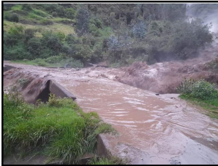
IMAGEN N° 06. PUENTE MANCARA 1 AFECTADO POR EL CAUDAL DE RIO MASCA
