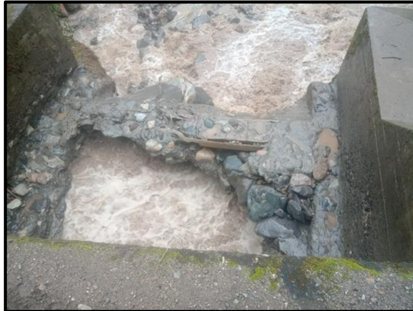
IMAGEN N° 09. SOCAVACIÓN DE ESTRIBOS DE PUENTE
