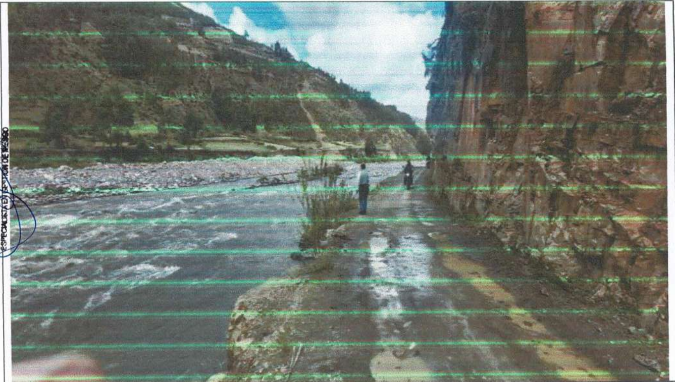
FOTOGRAFIA N° 02: Previa verificación del tramo identificado como puntos crítico requiere reforzar con roca al volteo de manera urgente, para garantizar una seguridad vial.
