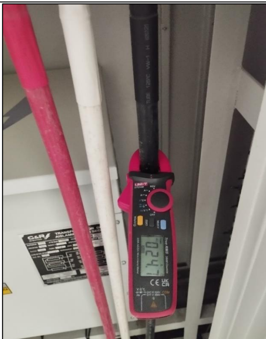
Foto 07: se observa desbalance de cargas.
