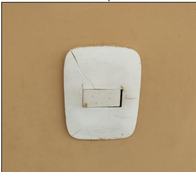
Foto 05: se observa tablero de PVC, este tablero deberá ser de metal
