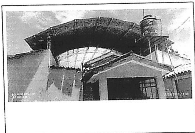
FOTO 04: SE OBSERVA DETERIORO DE TEJA ANDINA, MANTENIMIENTO DE ESTRUCTURA METALICA Y COBERTURA DE ETERNIT Y POLICARBONATO
