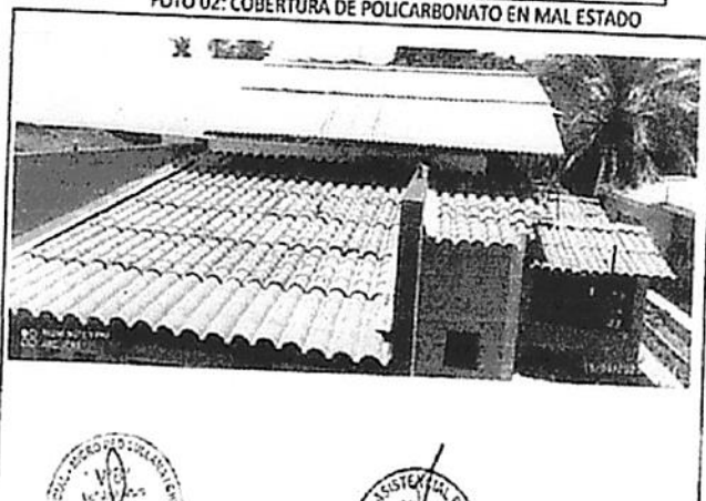
FOTO 02: COBERTURA DE POLICARBONATO EN MAL ESTADO
