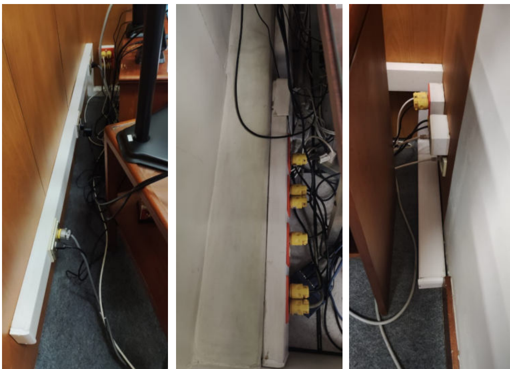
Fig.09-10-11. Estado de puntos eléctricos en soporte de canaletas
