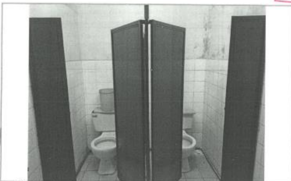
Mantenimiento de divisiones metálicas para cubículos de inodoros de SS.HH los cuales se encuentran con falta de cuidado se aplicara pintura anticorrosiva del mismo tono.
