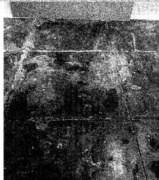
Foto 17: Vista de piso agrietado y con manchas de ingreso, zona central
