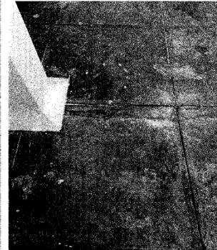
FOTO 21: Vista de piso agrietado y con manchas de ingreso, zona posterior.
