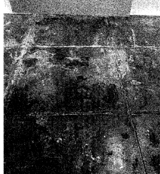
FOTO 20: Vista de piso agrietado y con manchas de ingreso, zona posterior
