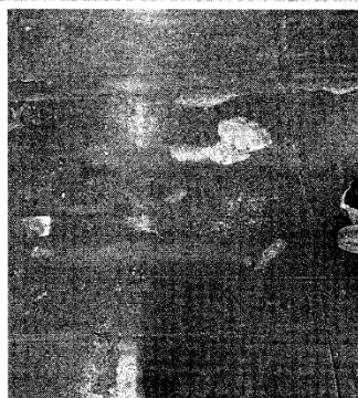
Foto 10: Vista de tipología de grietas identificadas de 1 a 2.5 cm de profundidad
