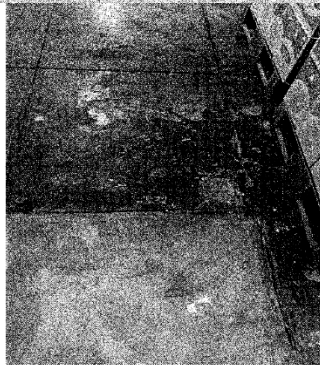
Foto 16: Vista de piso agrietado y con manchas de ingreso, zona central
