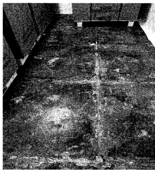
FOTO 19: Vista de piso agrietado y con manchas de ingreso, zona posterior
