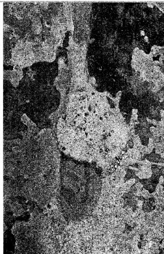
FOTO 5: Vista del estado situacional del piso descascaramiento del concreto con grietas de 1.5 cm
