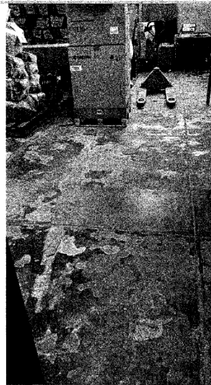
Foto 3: Vista del piso agrietado con descascaramiento del concreto
