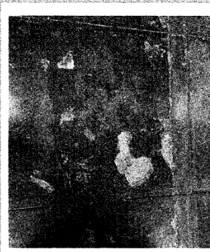
Foto 18: Vista de piso agrietado y con manchas de ingreso, zona central
