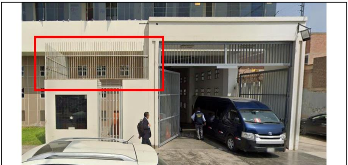
FOTO N°20: Mantenimiento, lijado y pintado de cerco metálico H=1.35m en ingreso INPE.
