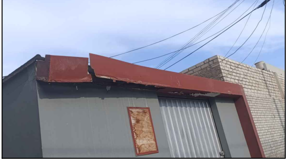
MANTENIMIENTO Y REPACACIÓN INTEGRAL DE DINTEL DEL DRYWALL, CANALETA DE DRENAJE Y PINTADO
