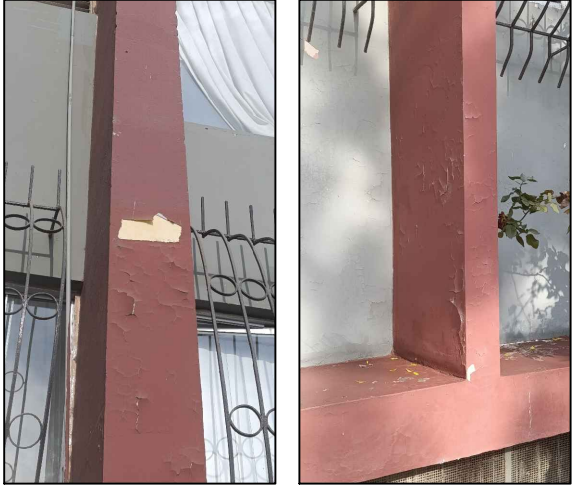
RETIRO TOTAL DE LA PINTURA ANTIGUA Y TRATAMIENTO DE LA SUPERFICIE.
