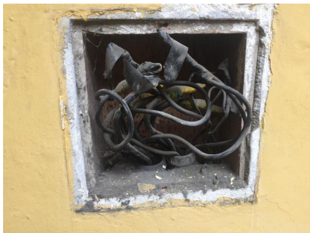
Figura N°08 – 09 / EMPALMES DEFICIENTES EN CAJA DE PASE
