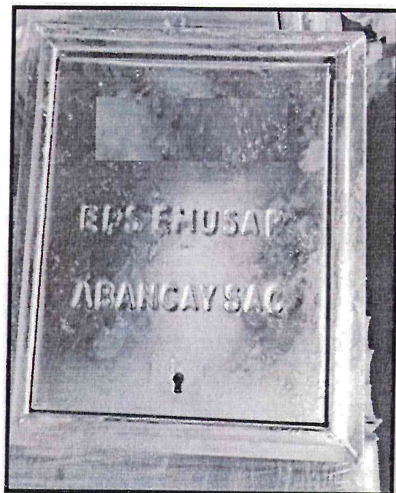
Imagen N° 01: Referencial de marcos y tapas de acero galvanizado - Agua
