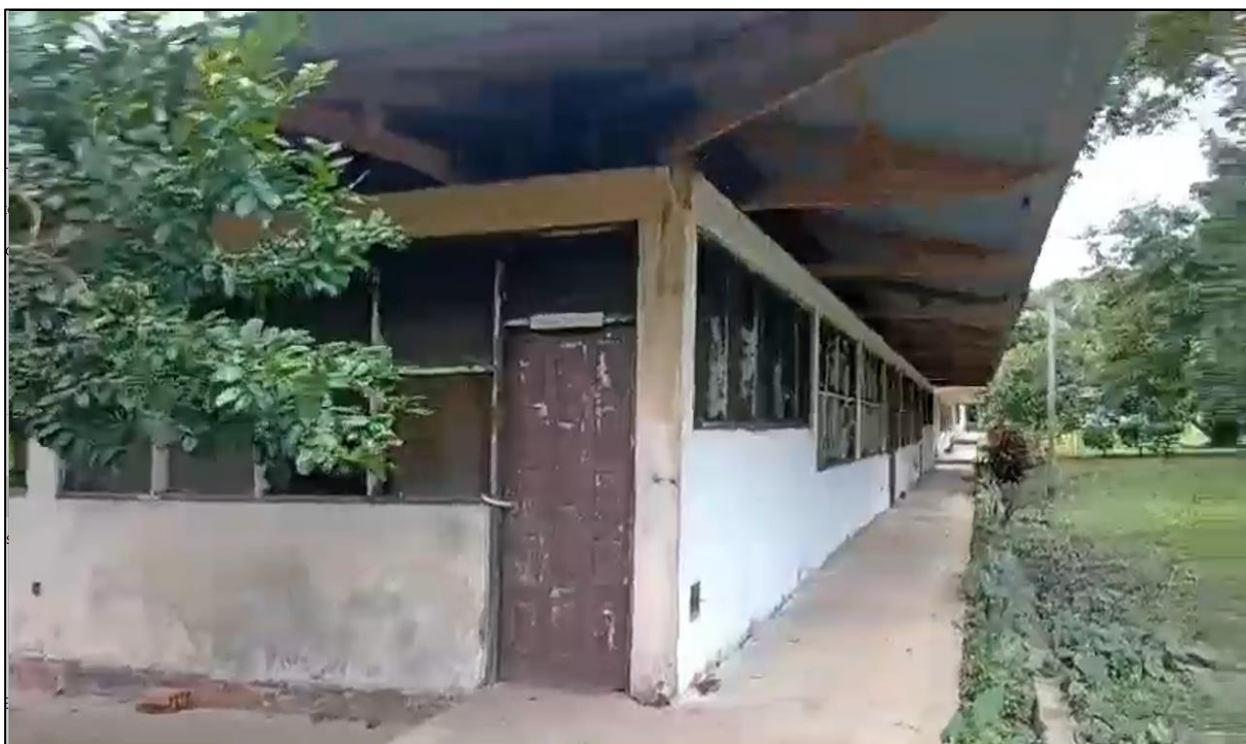
IMG. 04: Se visualiza el estado actual de los muros, ventanas, puerta de ingreso y vereda perimetral.
