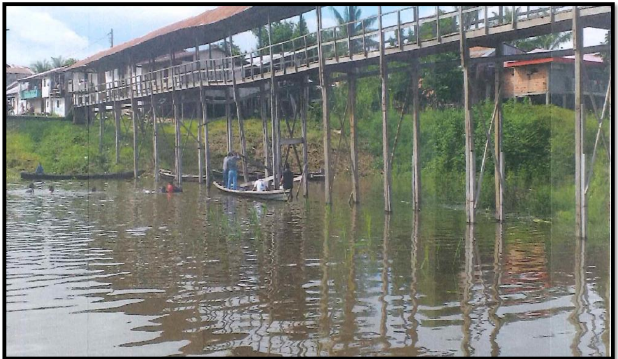
Foto N° 03: Columnas que soportan el puente de madera.
