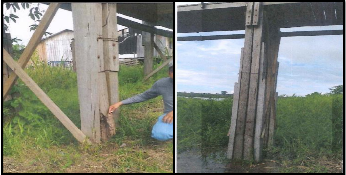
Foto N° 03: Columnas que soportan el puente de madera.
