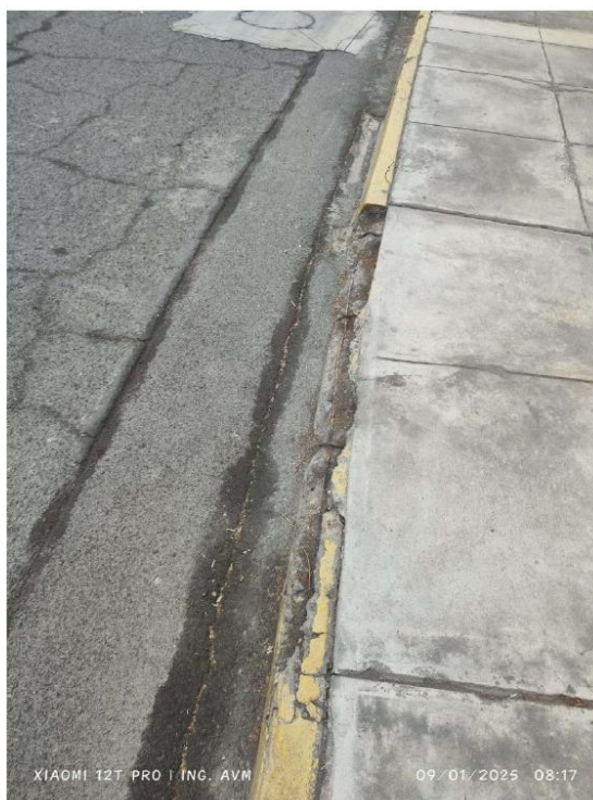
Figura 4 Agrietamientos longitudinales y desintegración de sardinel
