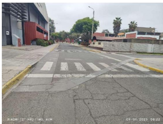
Figura 8 cruzadas en concreto en mal estado, falla en bloque parte central y agrietamiento longitudinal.
