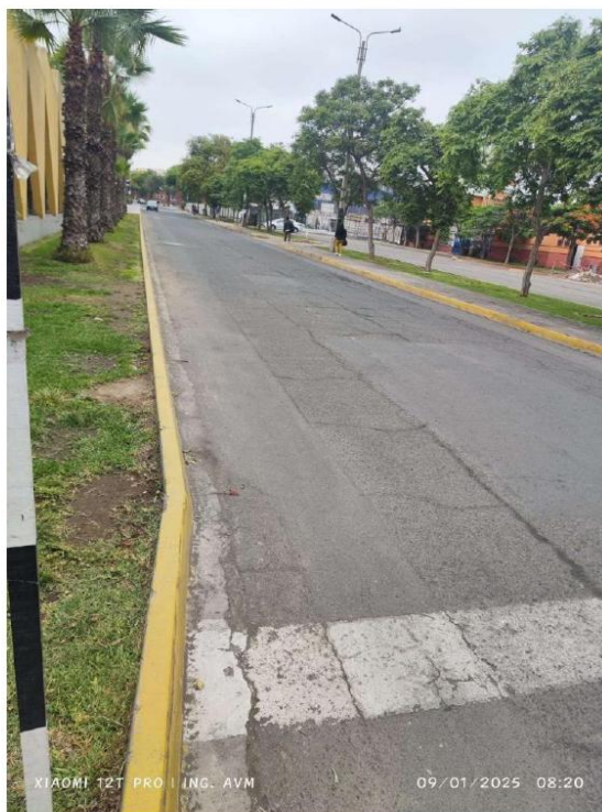
Figura 7 reparación antigua en mal estado, ahuellamiento y agrietamiento longitudinal
