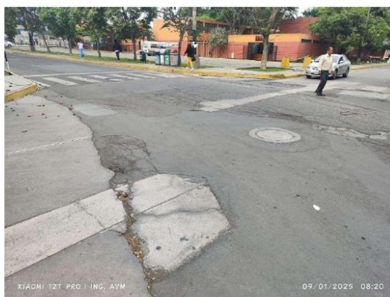
Figura 6 Reparaciones en concreto en mal estado, carpeta asfáltica desintegrada junto con piel de cocodrilo, agrietamientos
