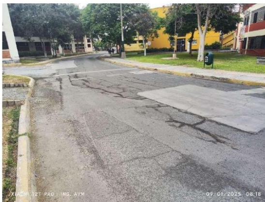
Figura 5 Reparaciones de concreto en mal estado (fracturado), ahuellamiento y bacheo
