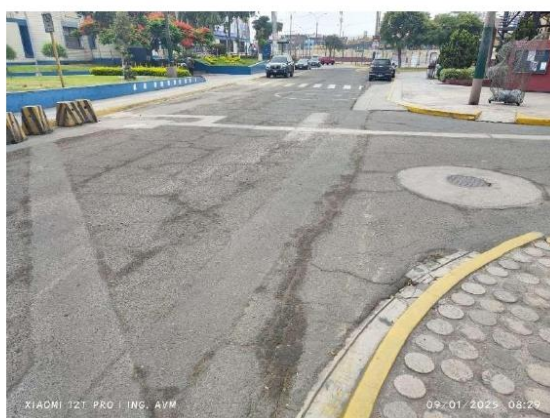
Figura 12 Agrietamiento, parches de trabajos de servicios y ahuellamiento.
