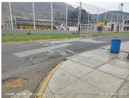
Figura 3 Reparaciones de concreto en mal estado (fracturado), ahuellamiento y bacheo.
