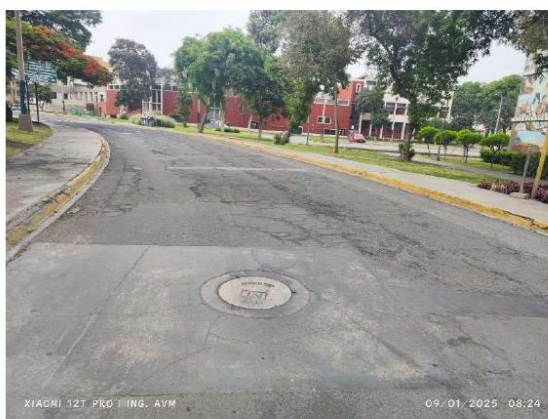
Figura 10 Piel de cocodrilo, ahuellamiento, reparación en concreto con agrietamientos.
