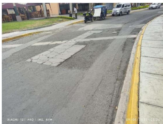
Figura 11 desintegración de pavimento asfáltico, reparación con concreto fracturado.
