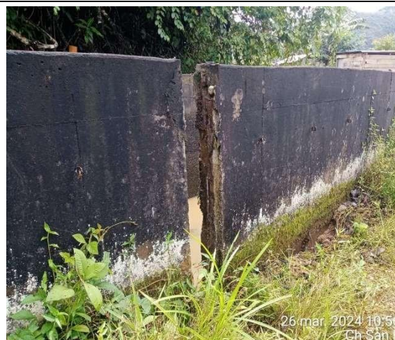
Imagen N° 02: separación de juntas y base afectado
