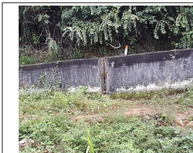
Imagen N° 01: separación de juntas en varios puntos
