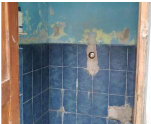
Vista de las manchas, exfoliación de la pintura, ausencia de cerámico. Se propone repintado y colocación de cerámico
