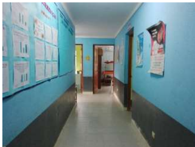
Vista de las paredes del corredor con mancha, ocasionado por el uso y paso del tiempo. Se plantea repintado.
