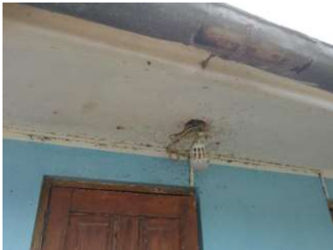
Vista de la Instalación del sistema de iluminación externa inadecuado. Se plantea la reinstalación. Ambiente de residencia
