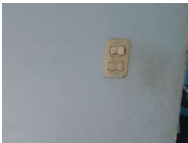
Vista del interruptor dañado. Se plantea su cambio. Ambiente cadena de frio
