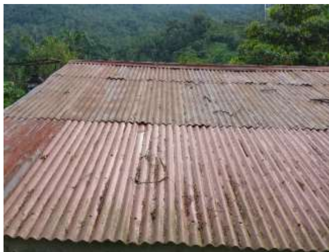
Vista donde se observa desprendimiento en las juntas de las planchas de calamina, e indicios de corrosión. Se plantea cambio de las planchas deterioradas. ambiente casa materna
