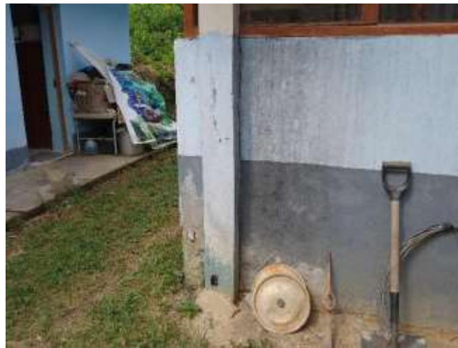
Vista donde se observa manchas en la pared externa del ambiente Triage. Se plantea repintado.
