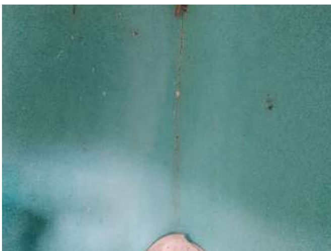
Vista donde se observa fisura y manchas, ocasionado por la humedad. Se plantea resane y repintado. Residencia.
