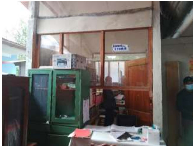
Vista donde se aprecia la ausencia de vidrio en la venta principal de admisión. Se plantea reposición.
