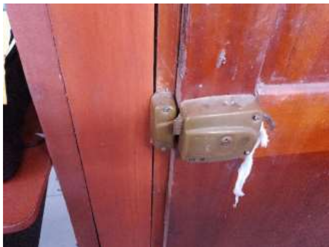
Vista de la chapa en mal funcionamiento. Se propone cambio de chapa-puerta de triaje.
