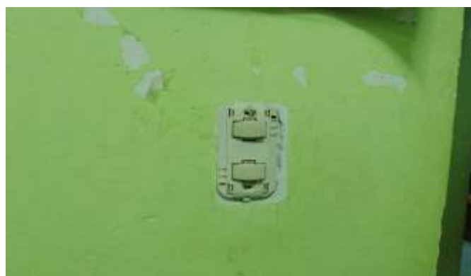
Vista donde se aprecia el interruptor en pésimo estado de conservación. Se plantea su cambio. Ambiente CRED.
