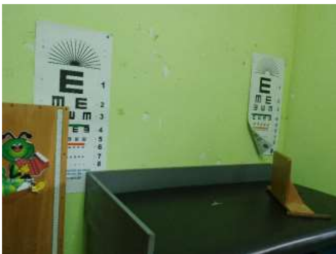
Vista de la pared con manchas y exfoliación de la pintura, causado por el paso del tiempo. Se plantea repintado.
