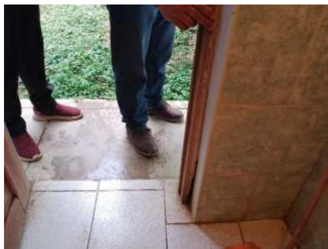
Vista del marco de la puerta de madera con deterioro, causado por la presencia de termitas. Se plantea su cambio. laboratorio
