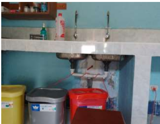
Vista donde se aprecia tubería de trampa y grifos tipo gancho del lavatorio dañados. Se planea su cambio. Laboratorio
