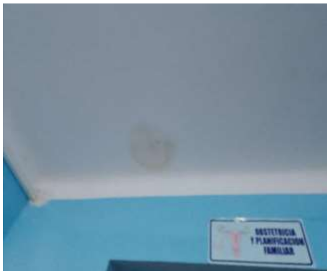
Vista donde se observa macha en el cielo raso, causado por la humedad. Se plantea repintado. Ambiente de Obstetricia
