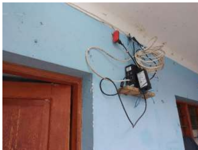
Vista del sistema de cableado expuesta y rollo de cable. Se plantea la reinstalación con carriles y retiro de cables excedentes. Ambiente laboratorio
