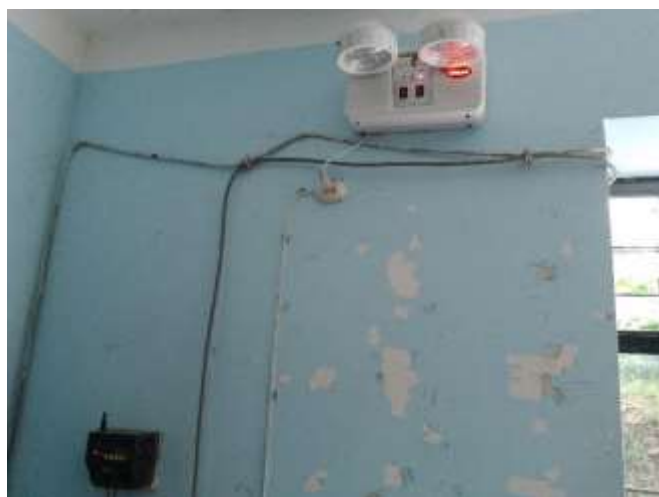
Vista de instalación eléctrica provisional, pintura exfoliada. Se plantea la reinstalación. Ambiente de cadena de frio.
