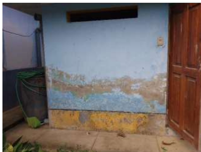
Vista de las fisuras y manchas en la pared y zócalo, ocasionado por la humedad y aguas pluviales. Se plantea resane y repintado
