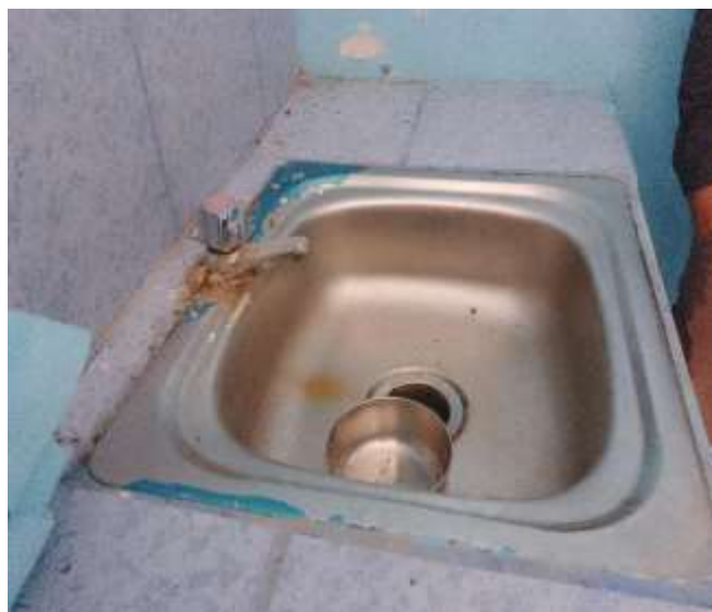
Vista del grifo del lavadero oxidado. Se plantea su cambio. Ambiente sala de parto
