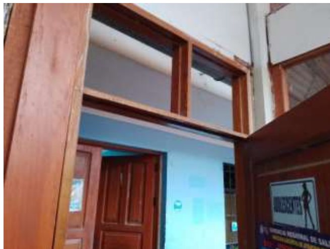
Vista que detalla ausencia de vidrio en el tragaluz. Se propone la colocación de vidrio. acceso a triaje.
