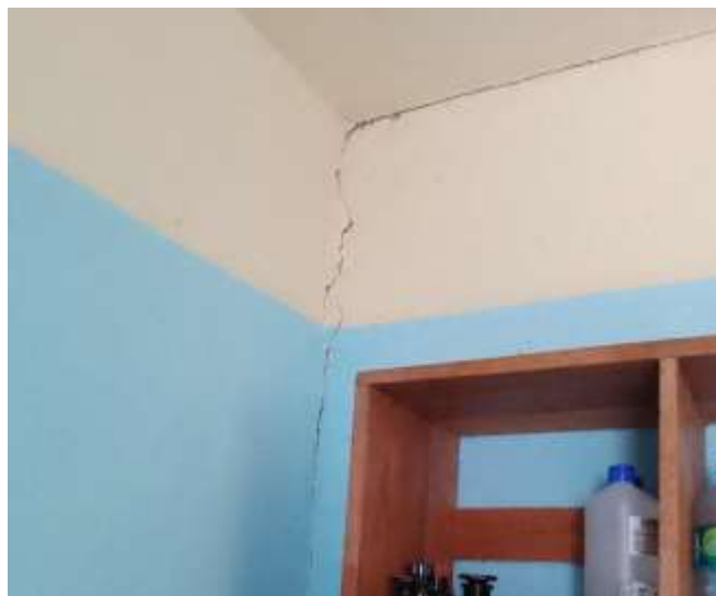
Vista donde se observa fisura en la esquina. Se plantea resane y repintado. Ambiente laboratorio
