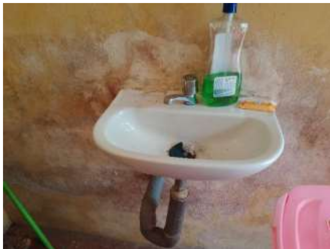
Vista de la exfoliación de la pintura, causada por la humedad y filtración de agua de la trampa de lava mano. Se plantea cambio y repintado. Ambiente ducha de profesionales
