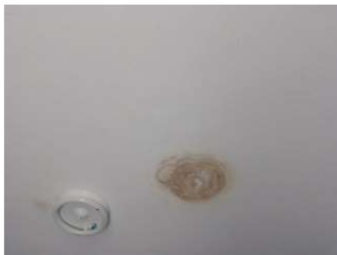
Vista de mancha en el cielo raso, ocasionado por la humedad. Se plantea repintado. Ambiente sala de parto.
