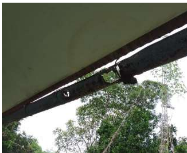
Vista de la canaleta con agujeros ocasionado por falta de mantenimiento. Se plante cambio. Alero posterior de la casa de partos
