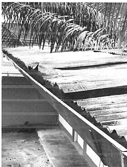
Imagen: Presencia mal estado de la cobertura, por la cual filtra el agua cada vez que llueve.
