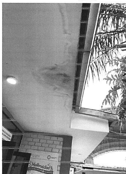
Imagen: Presencia de Humedad en el falso cielo raso producto de las lluvias que gotean por mal estado de las coberturas.
