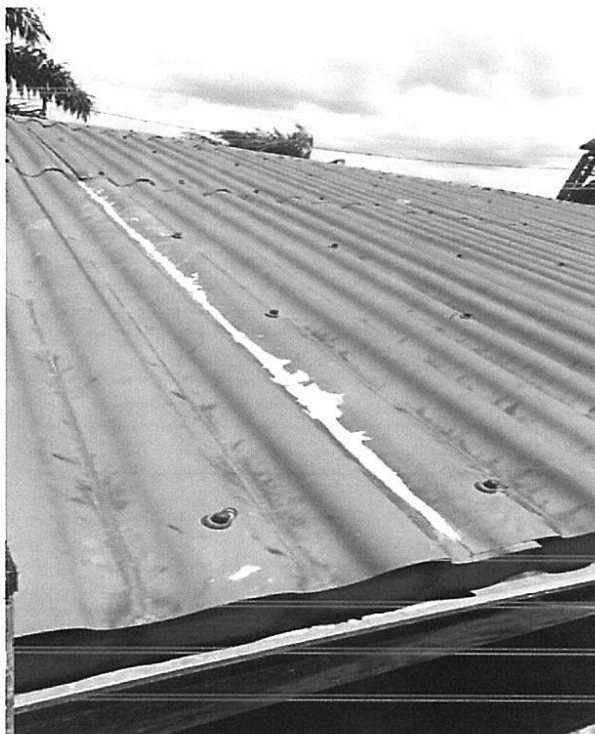
Imagen: Presencia mal estado de la cobertura, por la cual filtra el agua cada vez que llueve.
