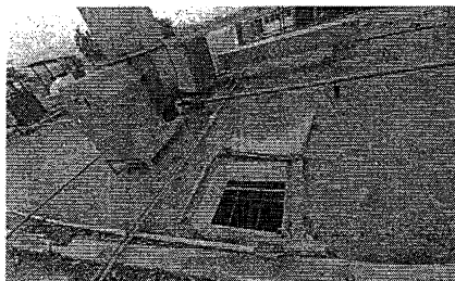
Foto N° 05: Ductos que están en mal estado dejando pasar la lluvia, se colocara estructura metálica con policarbonato y con vidrio templado..
