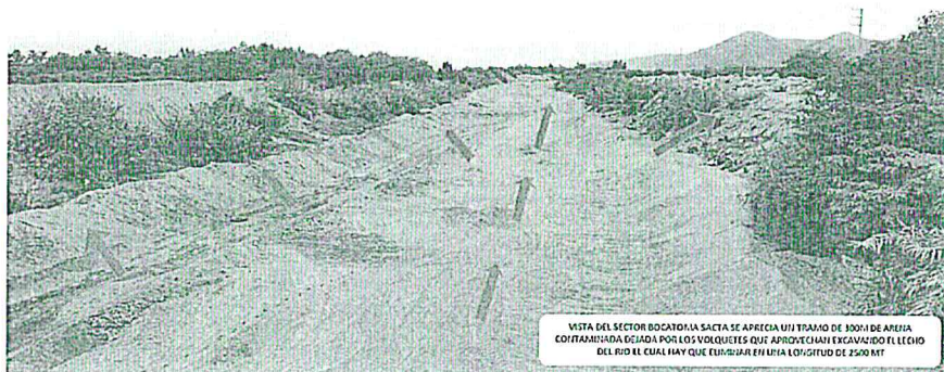
Foto 1: VISTA DEL SECTOR BOCATOMA SACTA SE APRECIA UN TRAMO DE 300M DE ARENA CONTAMINADA DEJADA POR LOS VOLQUETES QUE APROVECHAN EXCAVANDO EL LECHO DEL RIO EL CUAL HAY QUE ELIMINAR EN UNA LONGITUD DE 2500 MT
