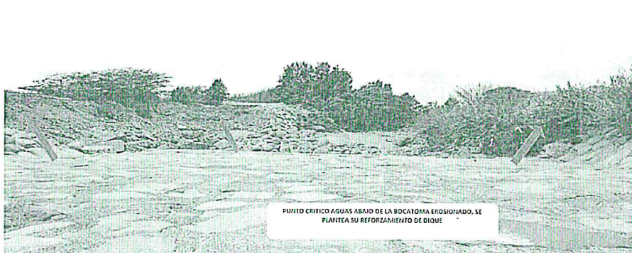
Foto 2: PUNTO CRITICO AGUAS ABAJO DE LA BOCATOMA EROSIONADO, SE PLANTEA SU REFORZAMIENTO DE DIQUE
