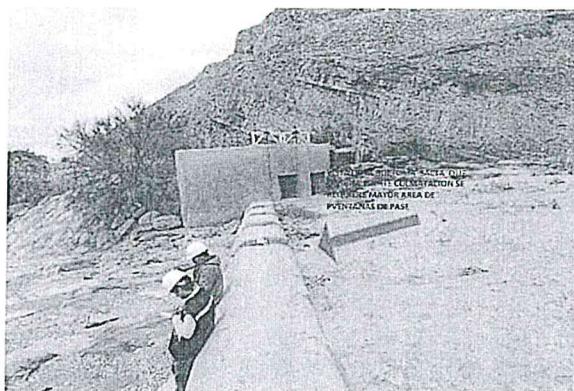
Foto 3: ZONA EROSIONADA POR LA CRECIDA DEL CAUCE PUNTO CRITICO FINAL DONDE SE NECESITA LIMPIEZA, DESCOLMATACION Y CONFORMACION DE DIQUE CON UNA LONGITUD DE 2500 MT EN AMBAS MARGENES
