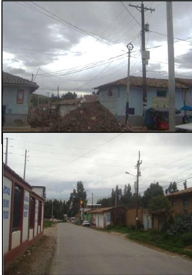
Fig. N° 05: Redes de media tensión incumpliendo distancias mínimas de seguridad
