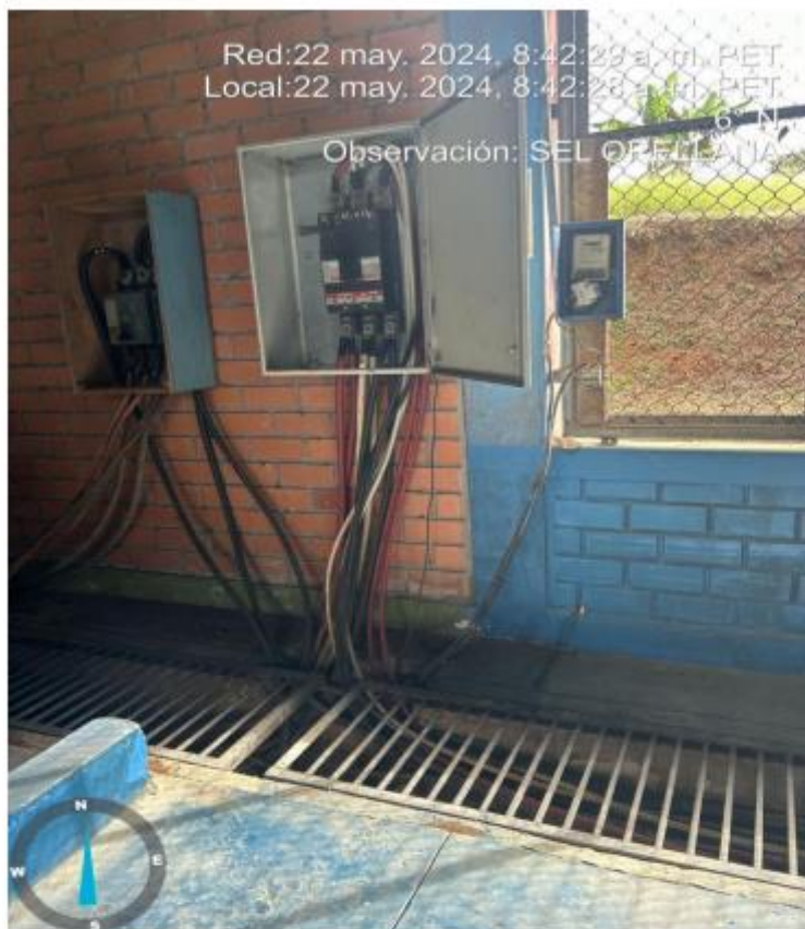
FOTO DE DUCTO DONDE SE COLOCARÁN LOS CABLES PARA EL GRUPO NUEVO
