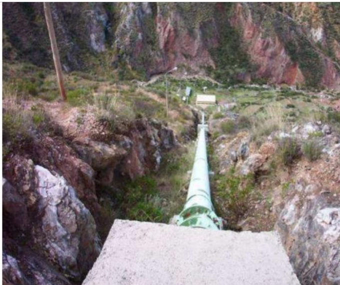
Tubería forzada, desde la cámara de carga
