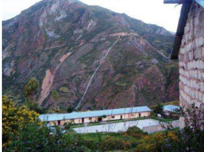
Tubería de presión de 572 m longitud x 0.45 m de diámetro de la CH Llusita
