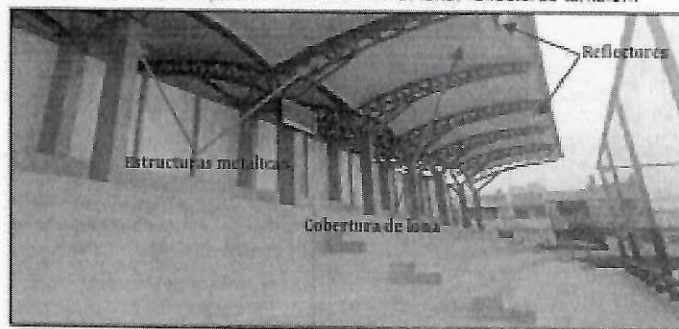
Fotografía N° 1: Estructura Metálica sobre gradenas en ambos sentidos a desmontar
