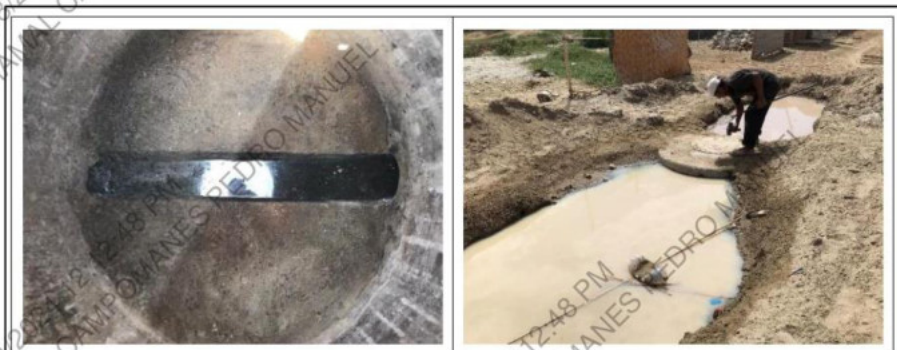
Imagen N°21: Buzones con tapas enterrados
