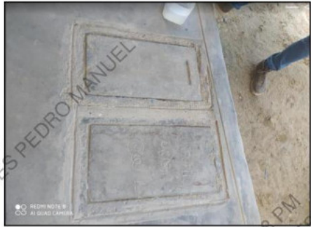
Imagen N°25: Cajas de desagüe con tapa de concreto
