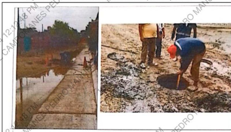
Imagen N°20: Buzones desbordados y colmatados, tapas rotas y maleza
