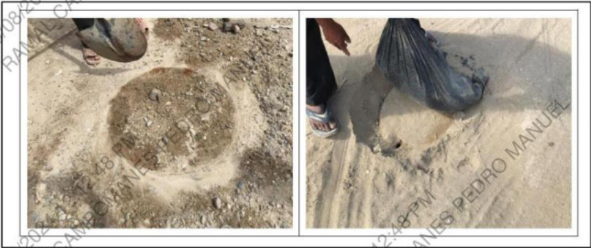
Imagen N°24: Buzones enterrados con tapas en mal estado
