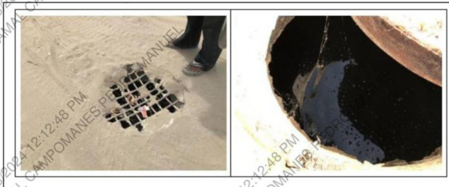
Imagen N° 19 : Buzones con tapas rotas e inundados
