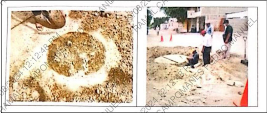
Imagen N°24: Buzones enterrados con tapas en mal estado
