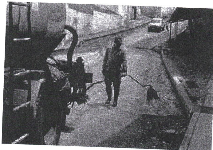
Foto N°01: Imprimación asfáltica (Foto Referencial)
