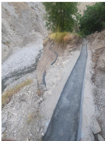
Ilustración 9: Situación actual de estado de la línea de conducción, tubería paralela a canal de concreto existente en ladera – visita correspondiente al mes de abril 2022
