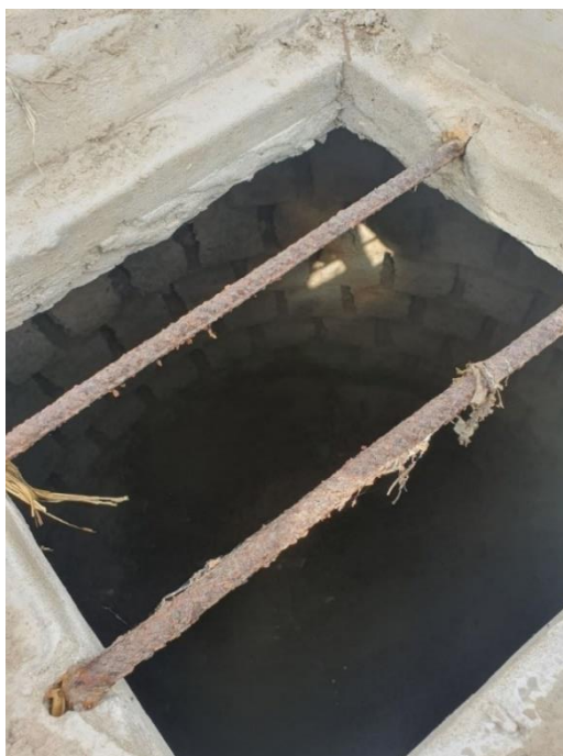
Ilustración 16: Pozo percolador
