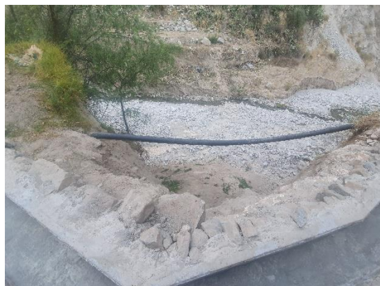
Ilustración 8: Situación actual de estado de la línea de conducción, tubería LC colgante– visita correspondiente al mes de abril 2022
