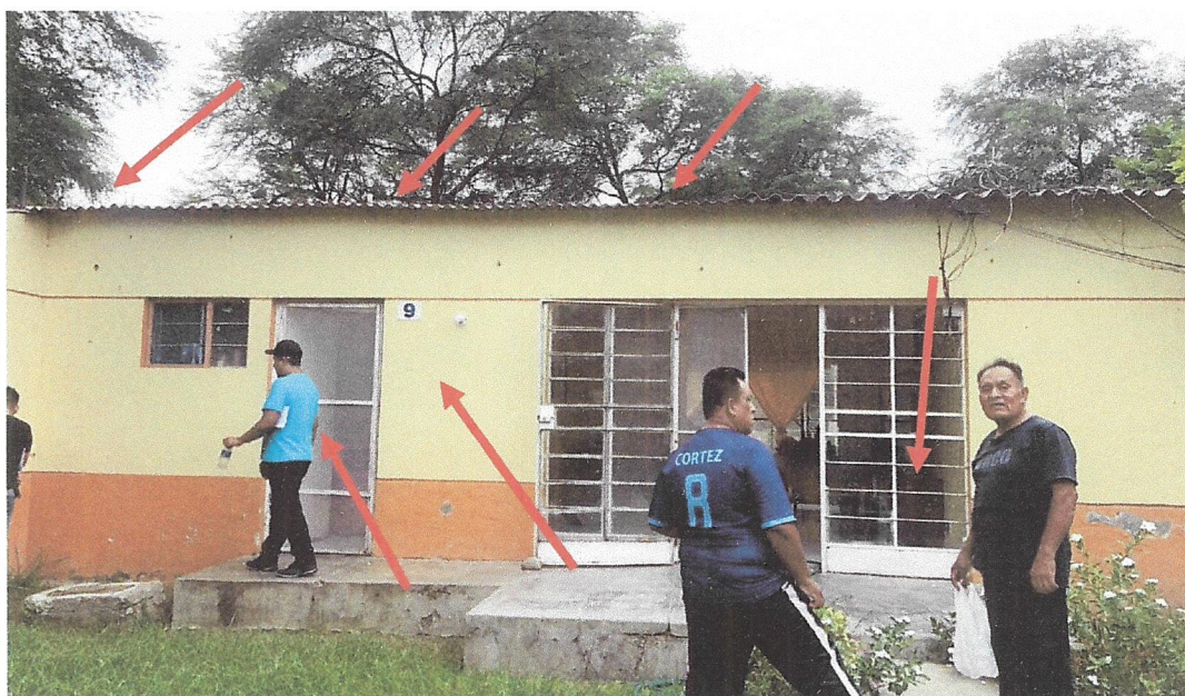
Fotografía 56: En las imágenes se observan manchas de suciedad en muro. -Se aprecia el deterioro del techo general existente, para cambio. -Se observa manchas y oxido en puerta metalaica, para mantenimiento.
