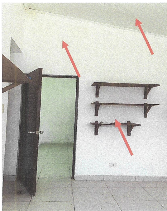
Fotografía 83 y 84: En las imágenes se observa manchas y suciedad en pared de lavandería, para mantenimiento -Se aprecia el deterioro nde techo existente en lavandería.
