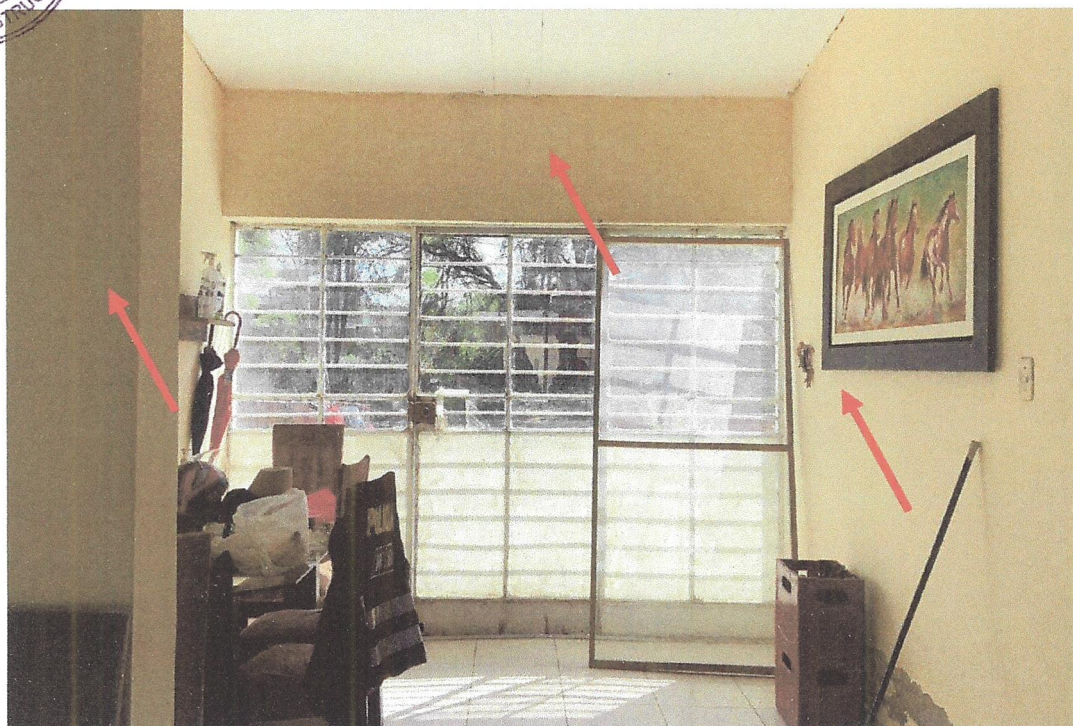
Fotografía 42,43 y 44: En las imágenes se aprecia el deterioro de falso cielorraso, para cambio. -Se observa manchas de suciedad en pared de la sala y comedor de la vivienda 06.
