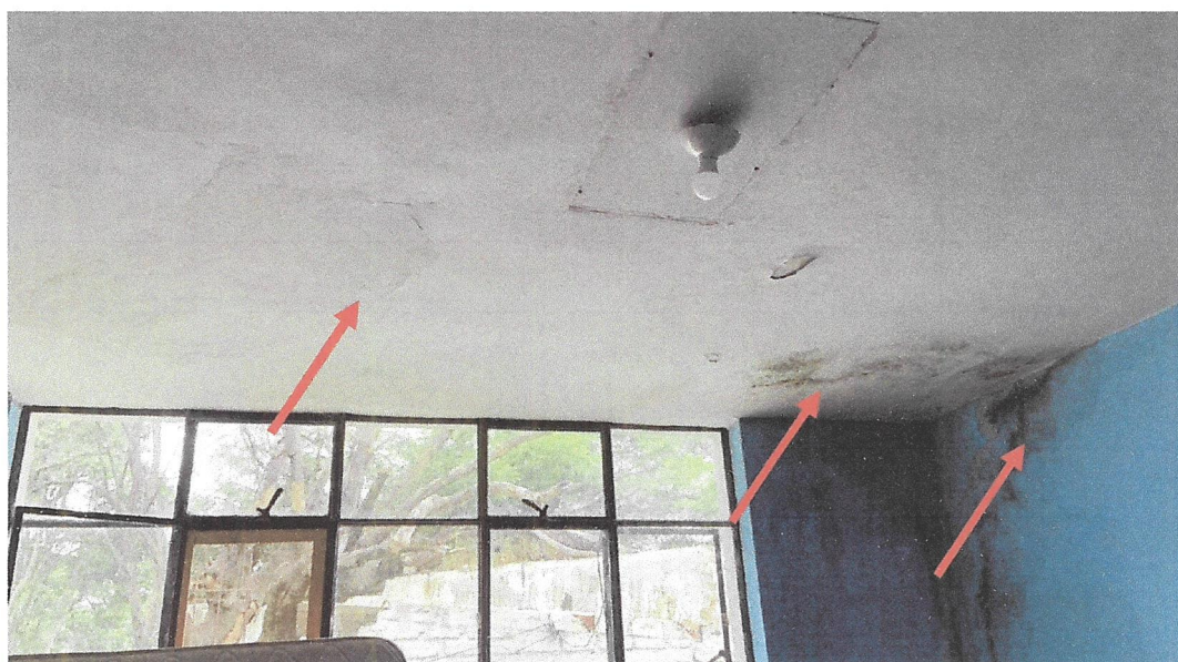
Fotografía 122, 123 Y 124: En la imagen se observa manchas de suciedad en paredes de dormitorios.
