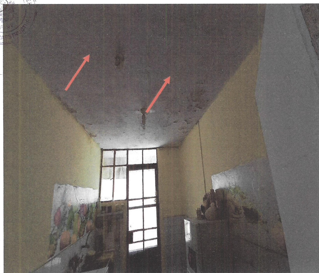
Fotografía 126,127 Y 128: En las imágenes se observa manchas de suciedad y humedad en muros y techo de la sala, comedor y cocina de la vivienda C1.
