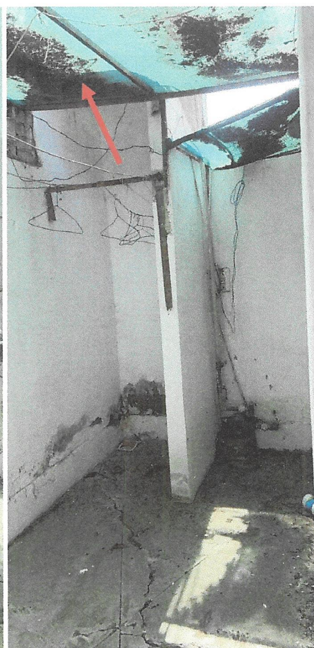
Fotografía 83 y 84: En las imágenes se observa manchas y suciedad en pared de lavandería, para mantenimiento -Se aprecia el deterioro nde techo existente en lavandería.
