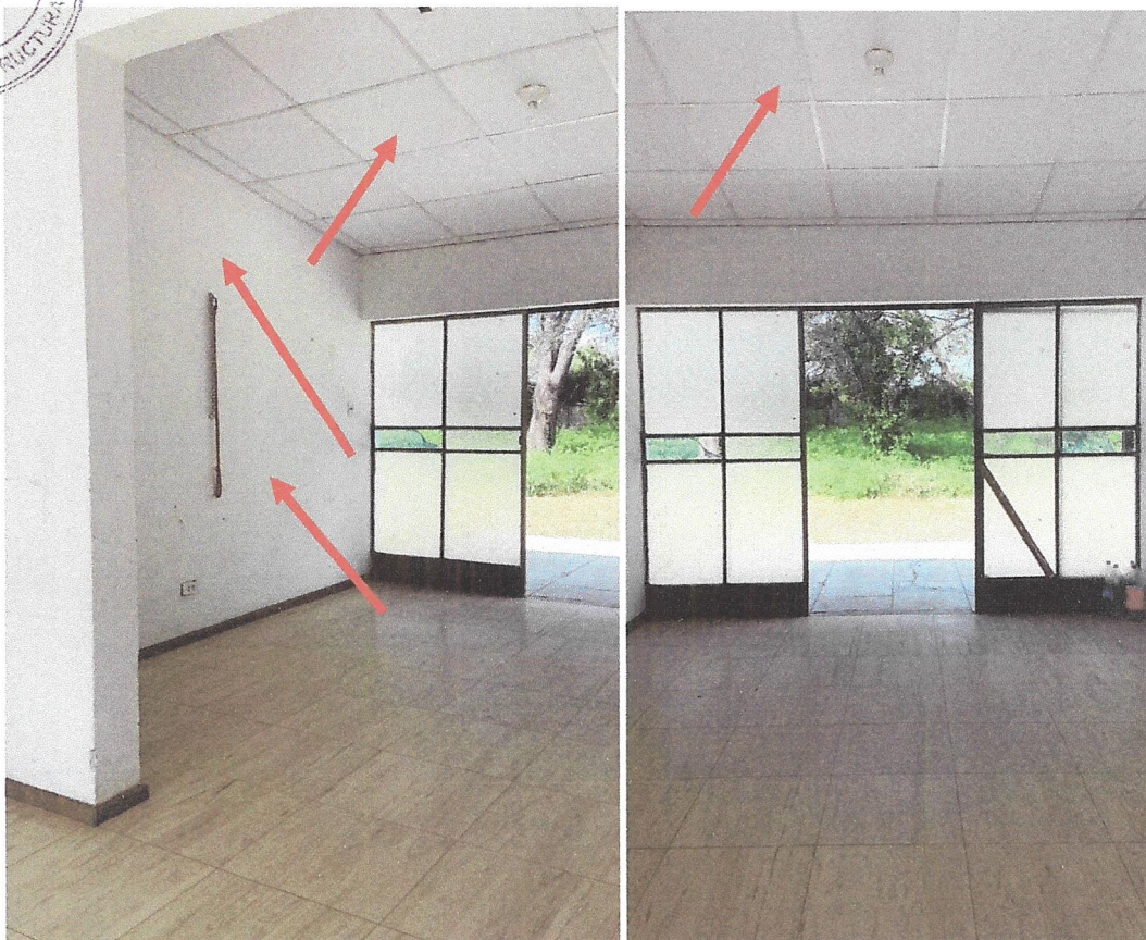
Fotografía 108 y 109: En la imagen se observa el deterioro de falso cielorraso en sala y comedor, para cambio. -Se aprecia manchas de suciedad en muros, para mantenimiento.
