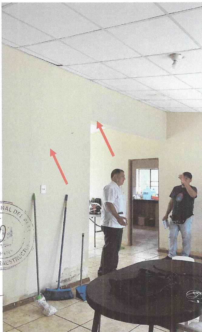
Fotografía 96 y 97: En las imágenes se observan manchas de suciedad en pared de sala y comedor, producto de los factores climatológicos.
