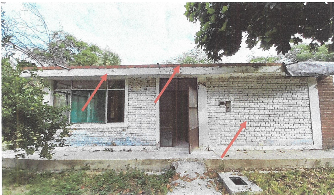
Fotografía 125: En la imagen se observa manchas de suciedad en muros de fachada de la vivienda C1.
