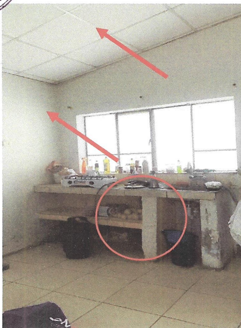
Fotografía 21 y 22: En las imágenes se aprecia el deterioro de falso cielorraso existente en cocina, para cambio.
