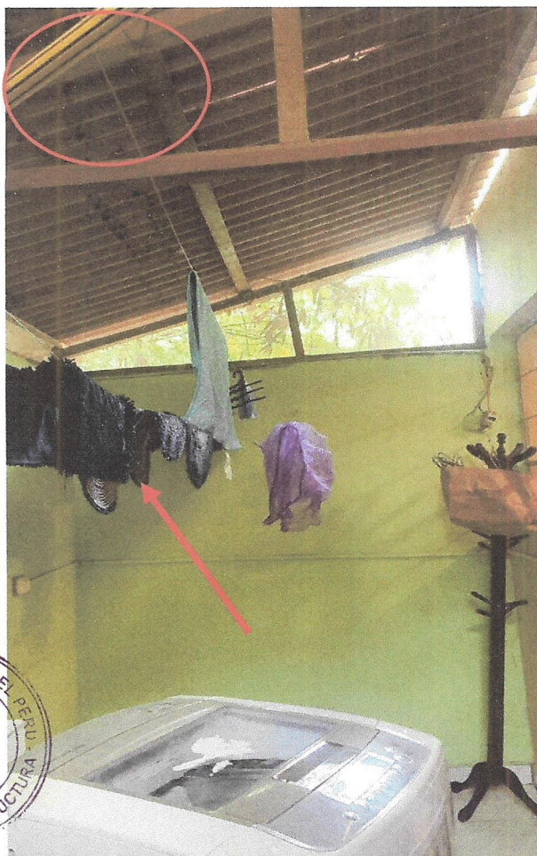
Fotografía 62 y 63: En las imágenes se aprecian el deterioro de techo existente (armaduras y cubierta)
