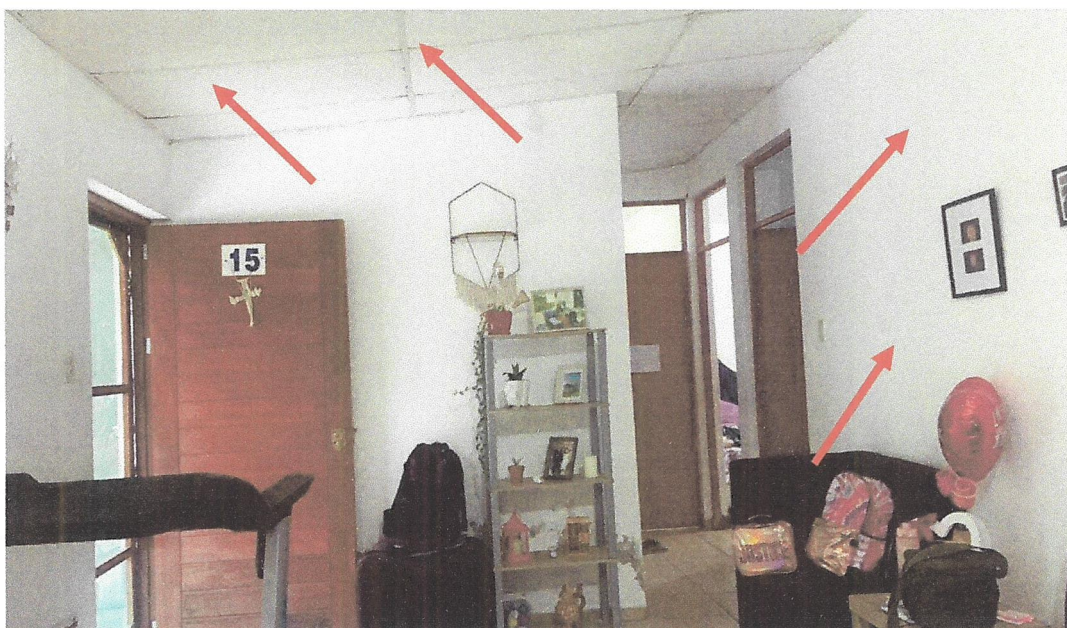
Fotografía 102 y 103: En las imágenes se observa el deterioro de falso cielorraso de la sala y comedor, para mantenimiento. -Se aprecia manchas de suciedad en pintura de muros de la sala y comedor.
