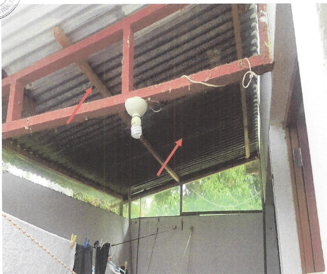
Fotografía 106: En la imagen se observa el deterioro de techo existente en lavandería, para cambio. -Se aprecia manchas de suciedad en pintura de muros de lavandería.
