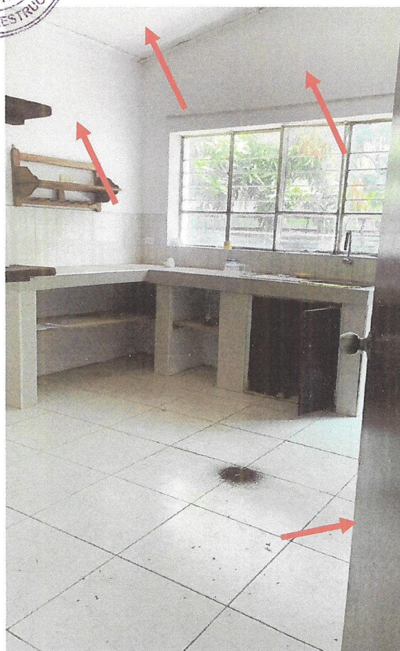
Fotografía 82: En las imágenes se observan el deterioro de falso cielorraso existente en cocina, para cambio.
