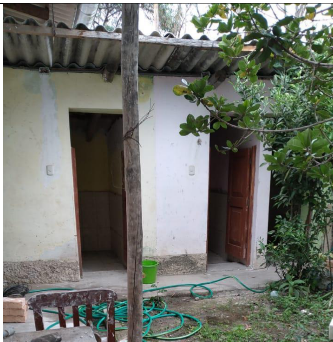
Fotografía N°04: Se visualiza el SS. HH, construido con material precario (adobe), se aprecia daños en la base de los muros a causa d la humedad, el techo mantiene filtraciones.
