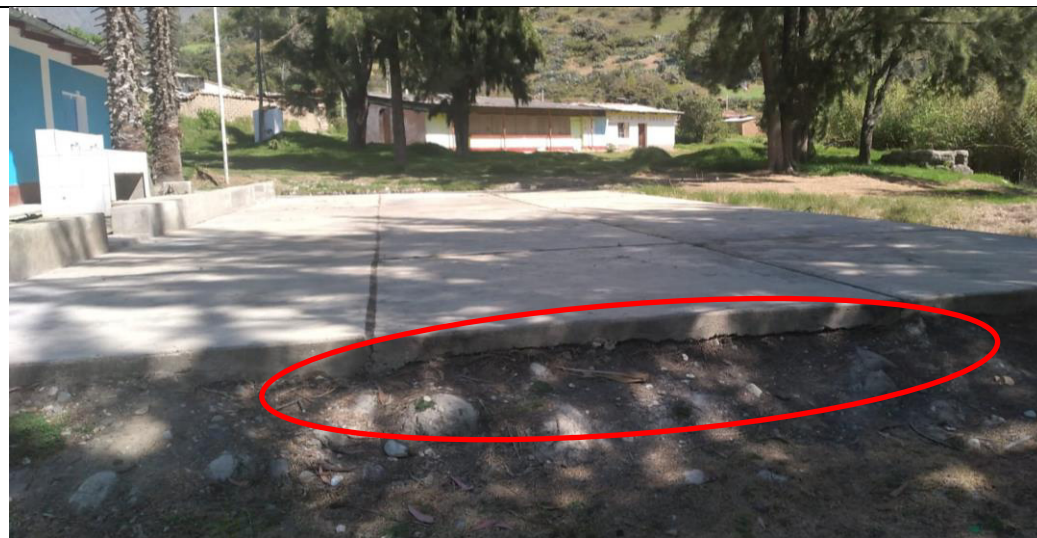
Fotografía N°05: Se visualiza losa de concreto, presenta erosión del agregado que conforma su base estructural (material natural).
