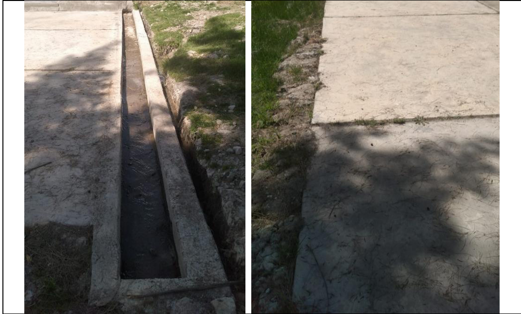
Fotografía N°06 y 07: Se visualiza acumulación de agua pluvial, debido a la falta de elementos de drenaje, la presencia de humedad en la base de la losa viene afectando su estructura.
