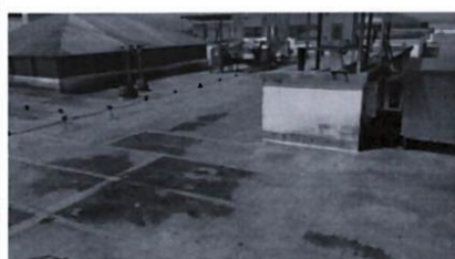
Foto 7: Impermeabilización De Techos (Asfalto Líquido) 4TO PISO
