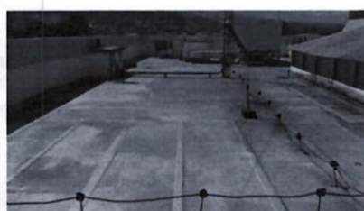
Foto 8: Impermeabilización De Techos (Asfalto Líquido) 4TO PISO
