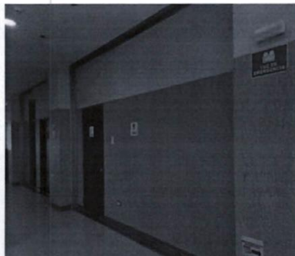
Foto 2: Mantenimiento de paredes, pintura látex oleo mate 2 manos incl. Imprimante (Muro Interior)
