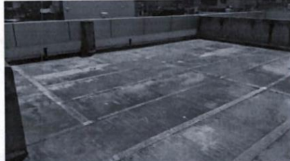
Foto 2: Impermeabilización De Techos (Asfalto Líquido) 4TO PISO
