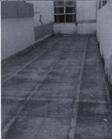
Foto 3: Impermeabilización De Techos (Asfalto Líquido) 3ER PISO
