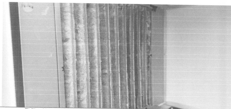
El filtro Hepa está colapsado, deja pasar todo tipo de elemento no deseado
