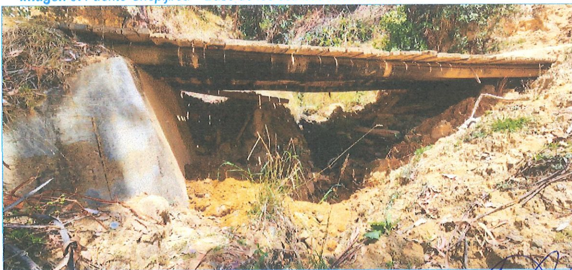
Imagen 3. Puente Chopijirca – Base de los estribos deteriorados
