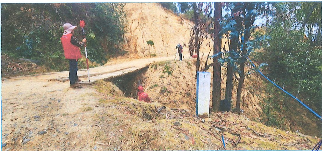
Imagen 5. Puente Chopijirca – Base de los estribos deteriorados
