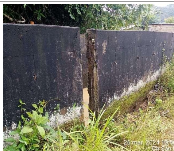
Imagen N° 02: separación de juntas y base afectado
