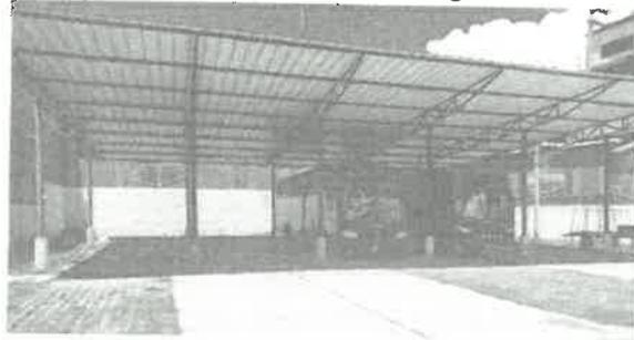
Pintura para estructura metálica: Gloss + Base Zincromato
