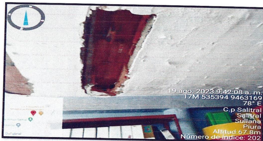
IMAGEN 03: Daño estructural en las viguetas del cielo raso – Daño estructural
