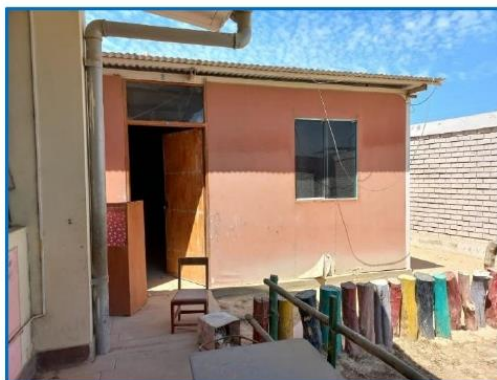
Fotografía 1 - Este ambiente está compuesto por muros de drywall. Por ser de material precario, se requiere de su desmontaje.
