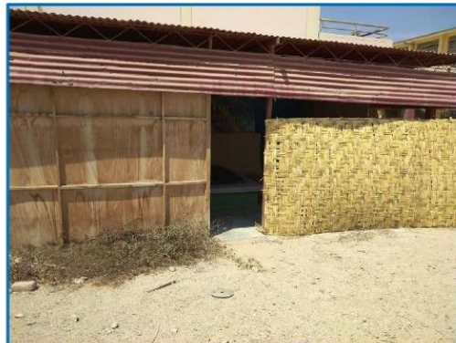
Fotografía 15 - Exterior del vestuario. Se aprecia el cerramiento precario del ambiente.
