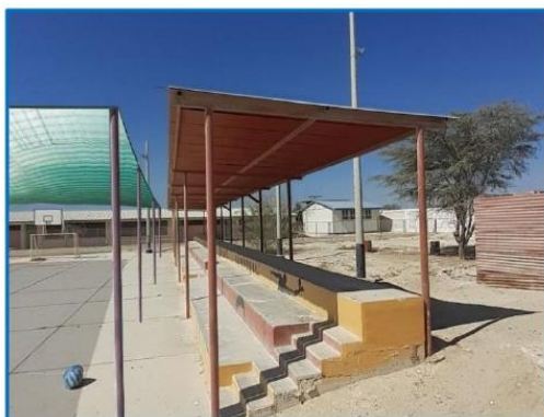
Fotografía 17 - Como se puede apreciar en la imagen, la cobertura metálica en las graderías, y las graderías en sí, han sido Autoconstruidas y durante el fenómeno del Niño, FEN 2017, fueron afectadas considerablemente, ya que el sistema de drenaje pluvial actual no f
