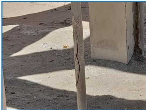
Fotografía 7 - Las tuberías del tanque elevado se encuentran en mal estado, y en algunos casos, rotas.
