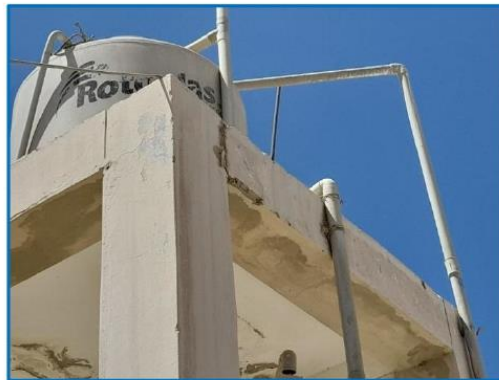
Fotografía 6 - Se aprecia que el tarrajeo de la estructura ha empezado a desprenderse en varios puntos.
