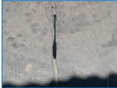
Fotografía 18 - Losas de plataformas presentan agrietamiento debido a los asentamientos producidos por el FEN 2017.
