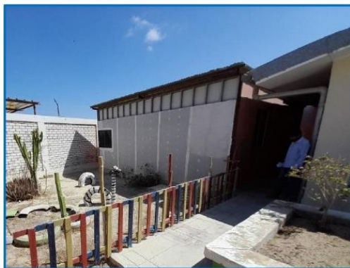
Fotografía 2 - El lado lateral de este ambiente no se encuentra con ningún tipo de acabado, y el soporte interno en la parte superior se encuentra expuesto.
