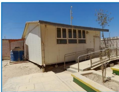
Fotografía 11 - Aula prefabricada suministrada por PRONIED, afectada por el FEN 2017, canaletas aéreas y montantes.
