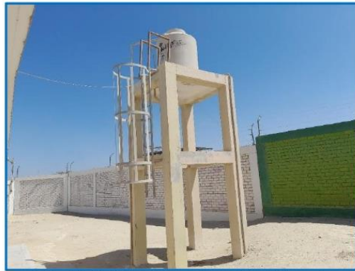
Fotografía 5 - Tanque elevado exclusivo del nivel inicial. La parte superior de la escalera tipo marinero se encuentra oxidada, y la pintura de la estructura de concreto está deteriorada.
