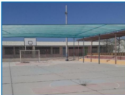
Fotografía 16 - Actualmente, las losas deportivas cuentan con una cobertura provisional de malla raschell. Esta malla se encuentra en mal estado, debido al rápido desgaste que dicho material sufre al estar expuesto al sol por tiempo prolongado.
