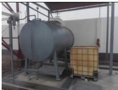
Tanque externo de Diésel
