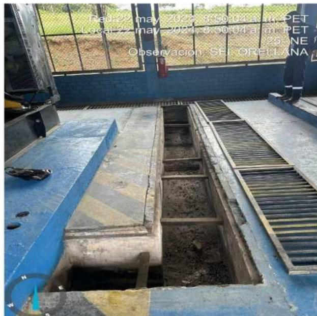
FOTO DE DUCTO DONDE SE COLOCARÁN LOS CABLES PARA EL GRUPO NUEVO
