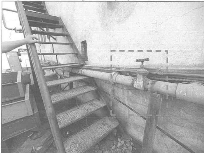
Imagen N°02. Tubería de fierro galvanizado – parte posterior del Reservorio N°01
