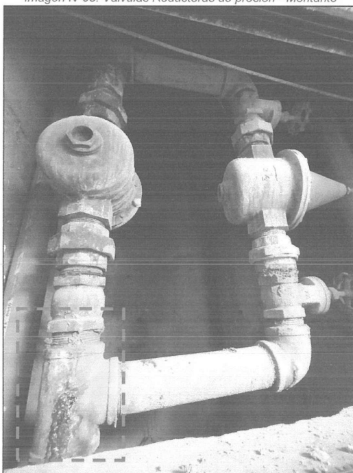
Imagen N°05. Válvulas Reductororas de presión - Montante
