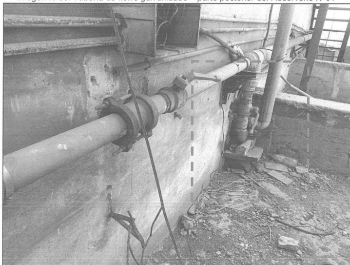
Imagen N°03. Tubería de fierro galvanizado – parte posterior del Reservorio N°01
