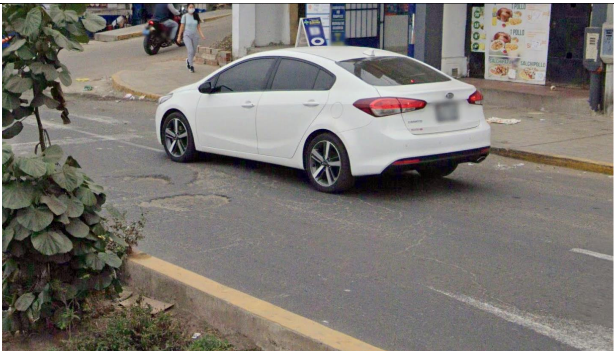
Figura Nº 05. Se observa que el pavimento existente se encuentra descascarando, fallas por pieles de cocodrillo, fallas transversales y longitudinales.
