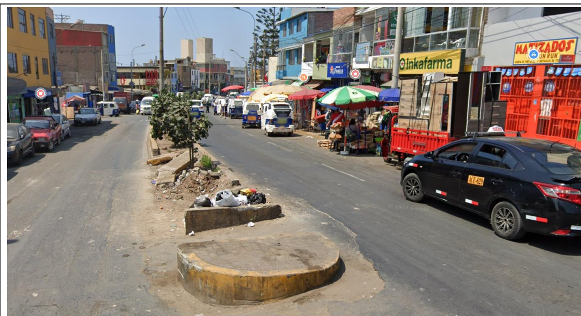
Figura Nº 05. Se observa la berma central completamente deteriorada, los sardineles ya se encuentran fisurados, agrietados, presentando señales de descascamiento ya que se observa el acero que se utilizó en su construcción., el pavimento también se encuentra con fallas longitudinales y transversales.
