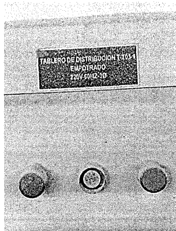
Imagen 24. SUBTABLERO DE TALLERES T-T03-01, 220V, 60Hz, 3F
