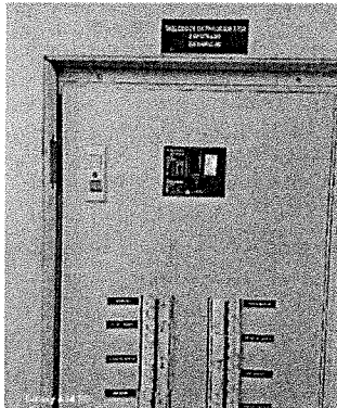
Imagen 23. SUBTABLERO DE TALLERES T-T03, 220V, 60Hz, 3F
