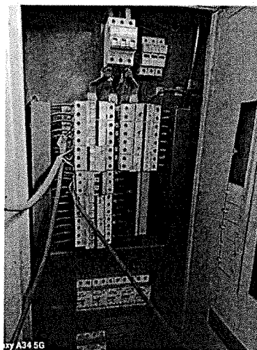
Imagen 25. SUBTABLERO DE TALLERES T-T04, 220V, 60Hz, 3F
