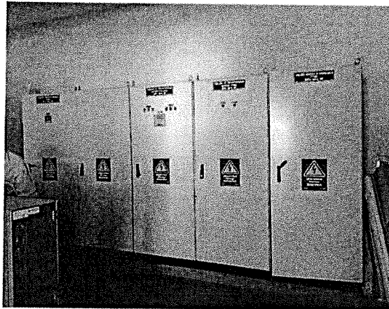
Imagen 6. Tablero general (TGN), tablero de transferencia automática (TTA), tablero de transferencia manual (TTM) y tablero general de emergencia
