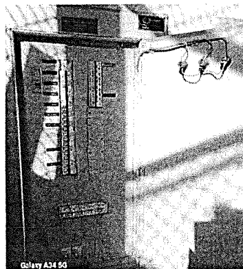
Imagen 22. SUBTABLERO DE TALLERES T-T02-01, 220V, 60Hz, 3F
