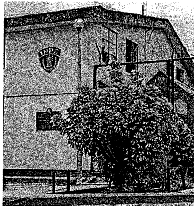
Imagen 28. LUMINARIA Na 150W 220V EN FAROLA
