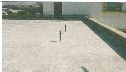
VISTA PANORAMICA: AZOTA DONDE SE APRECIA LA CAPTACIÓN DE DRENAJE PLUVIAL Y LA SALIDA DE DOS TUBOS DE VENTILACION
